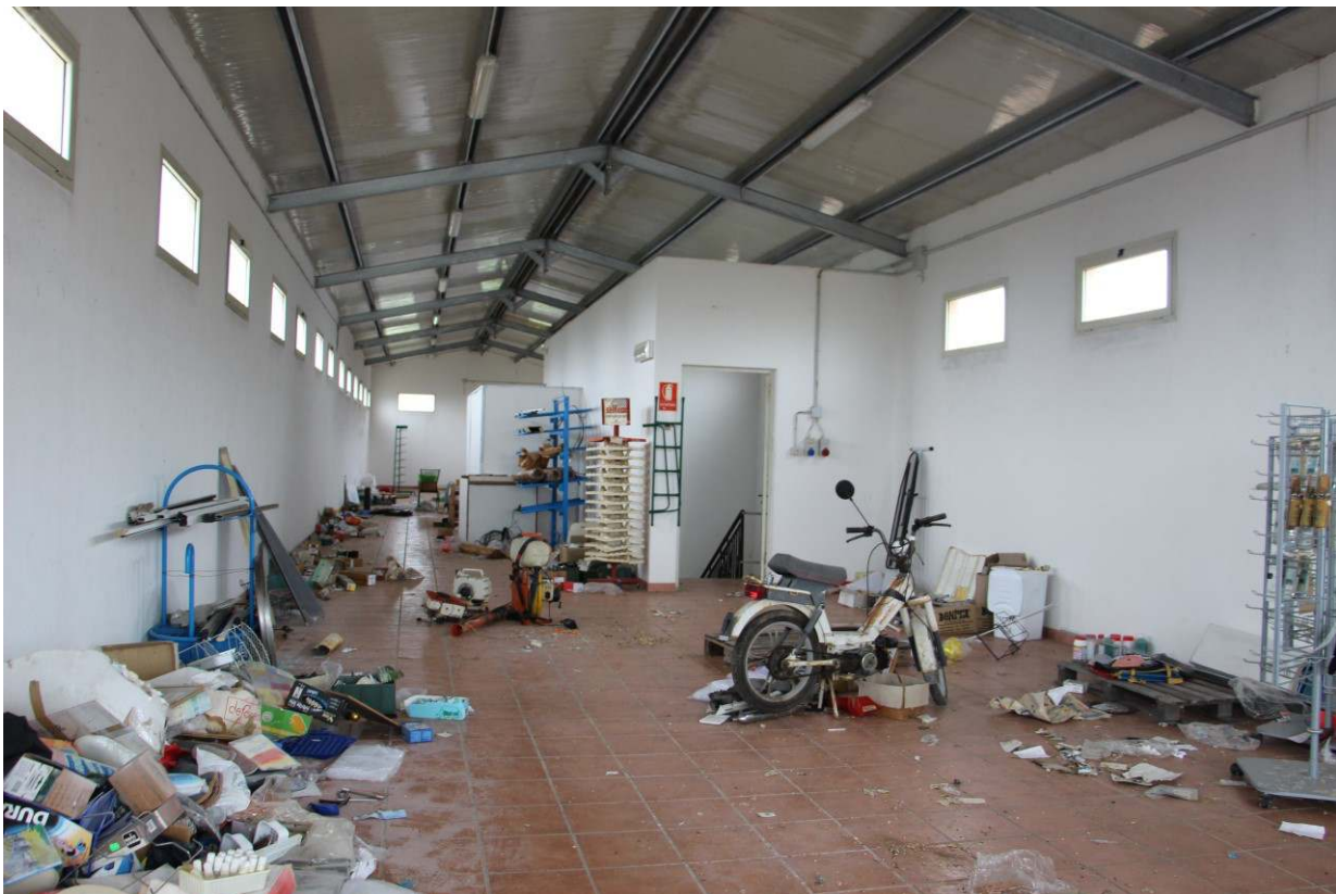
Vista dell'interno al piano terra
