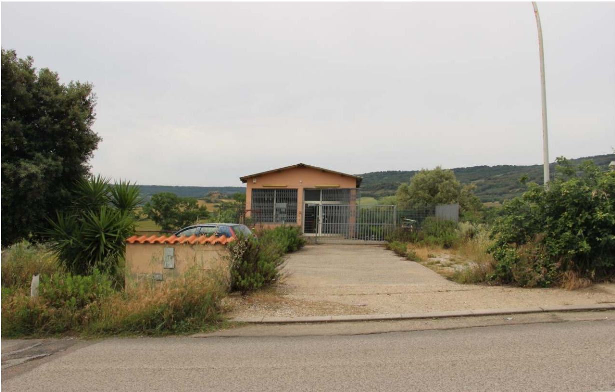
Accesso dalla strada provinciale e facciata principale
