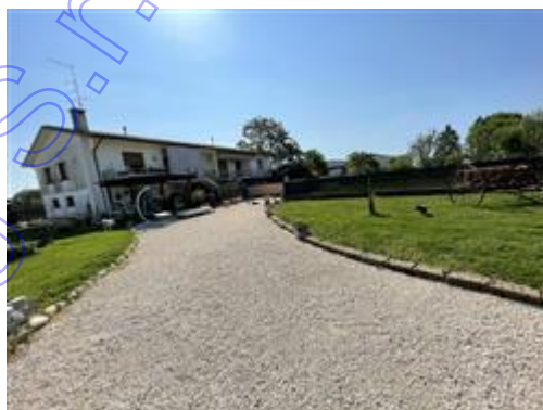
Ingresso e prospetto principale.
