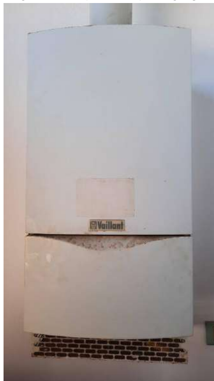
FOTO 42 – CALDAIA VAILLANT PRODUZIONE ACS
