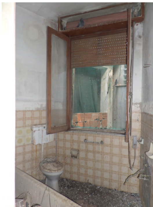
Foto n° 1.12. Piano primo: Bagno
