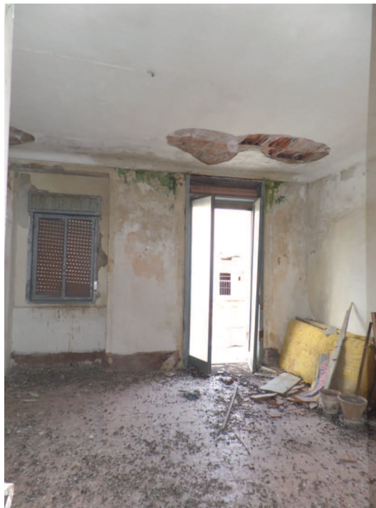
Foto n° 1.10. Piano primo: Cucina
