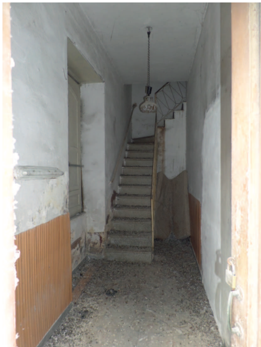
Foto n° 1.5. Piano Terra: vista scala
