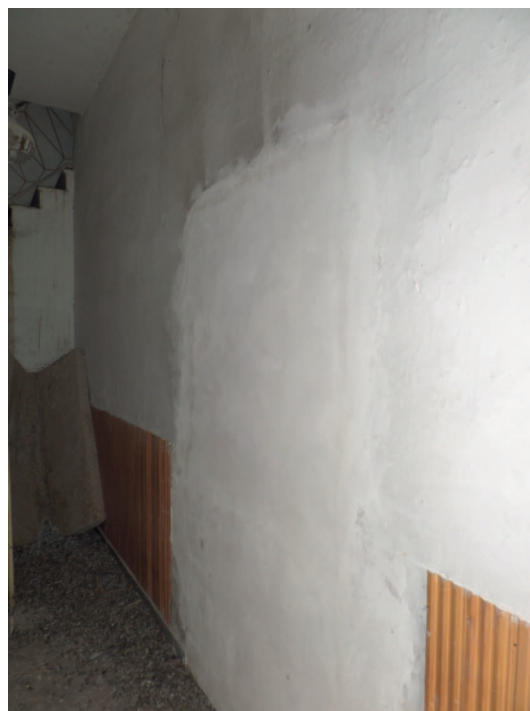
Foto n° 1.8. Piano Terra: particolare Ingresso
