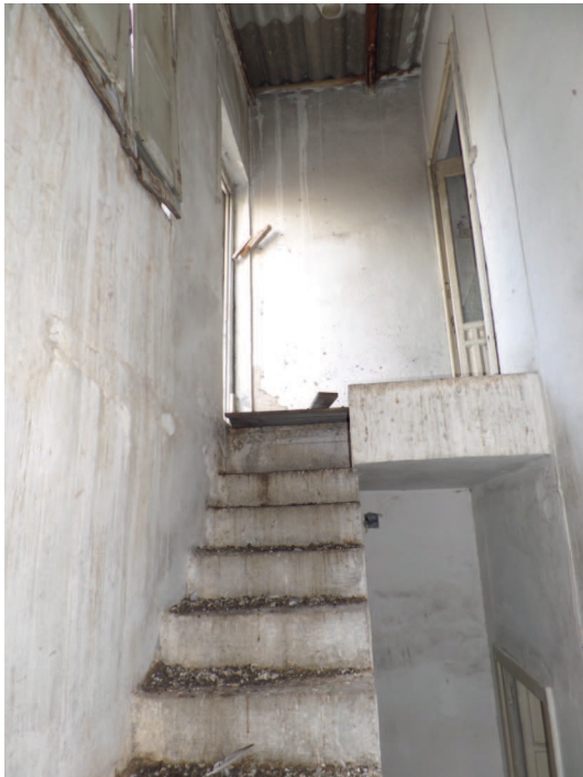
Foto n° 1.13. Scala Piano Primo - Piano Secondo
