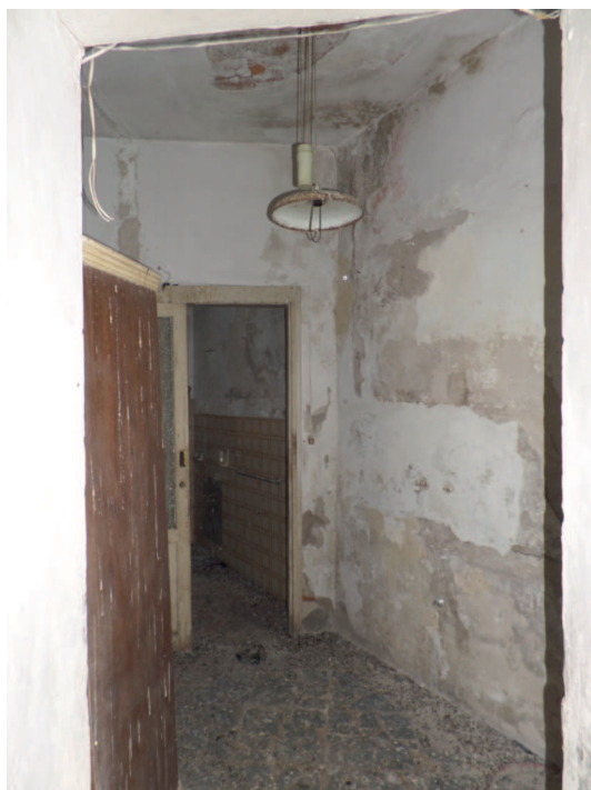
Foto n° 1.11. Piano primo: Camera
