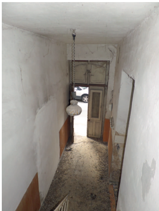
Foto n° 1.7. Piano Terra: ingresso
