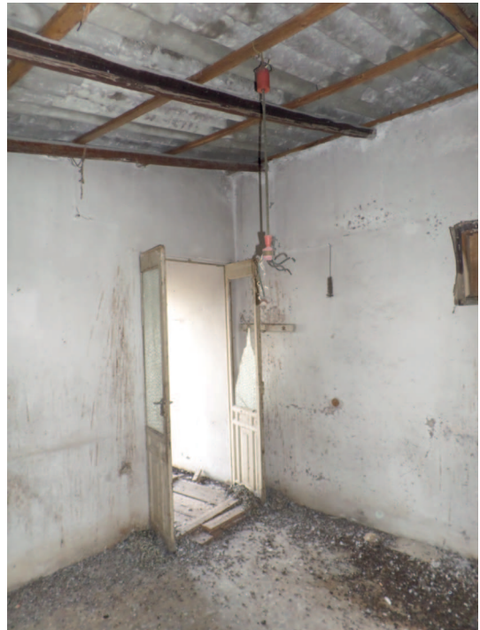
Foto n° 1.14. Piano Secondo: Lavanderia
