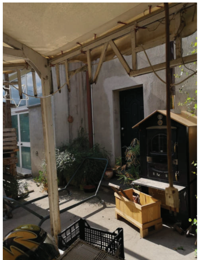
Foto 3 - Vista dell'accesso alla scala (part. 108 sub. 5) e della corte (part. 108 sub. 9)
