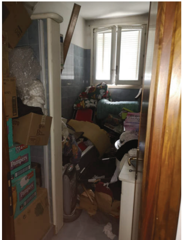
Foto 7 – Abitazione piano 1°, bagno (part. 108 sub. 7)
