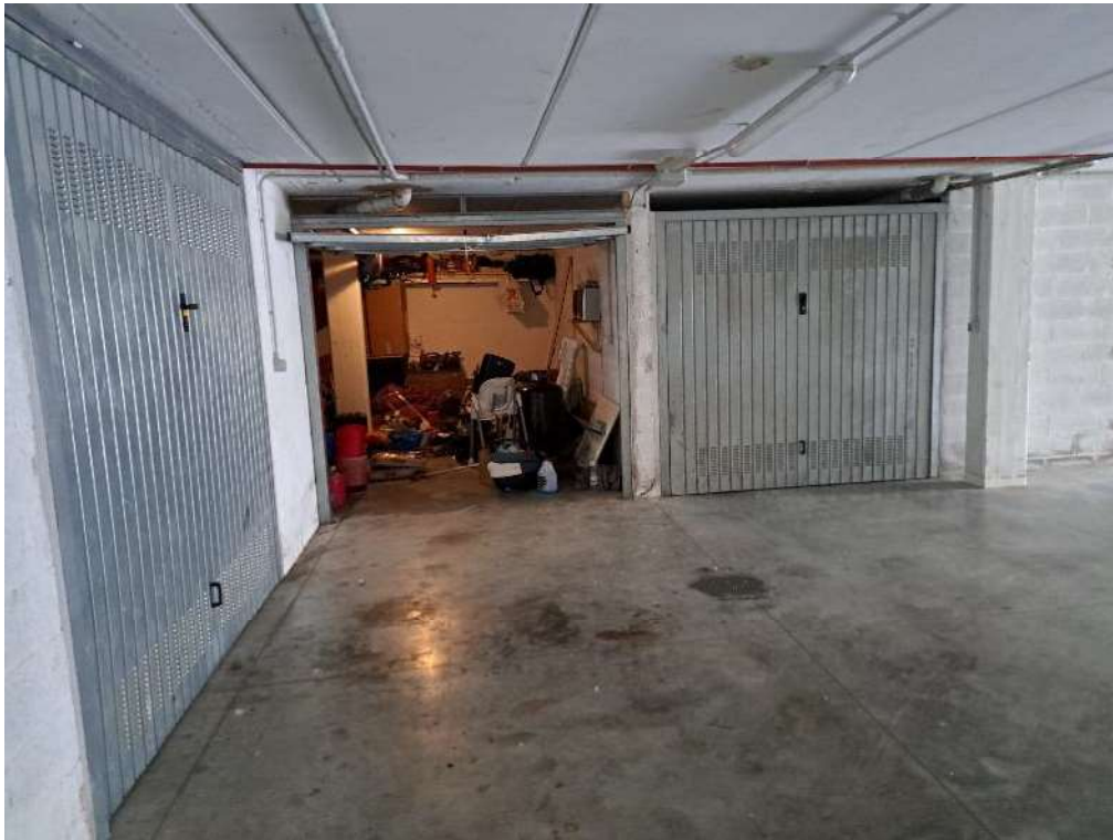
Foto 9 - Piano primo sottostrada, garage
