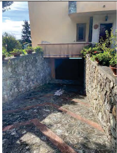
Accesso carrabile garage piano seminterrato
