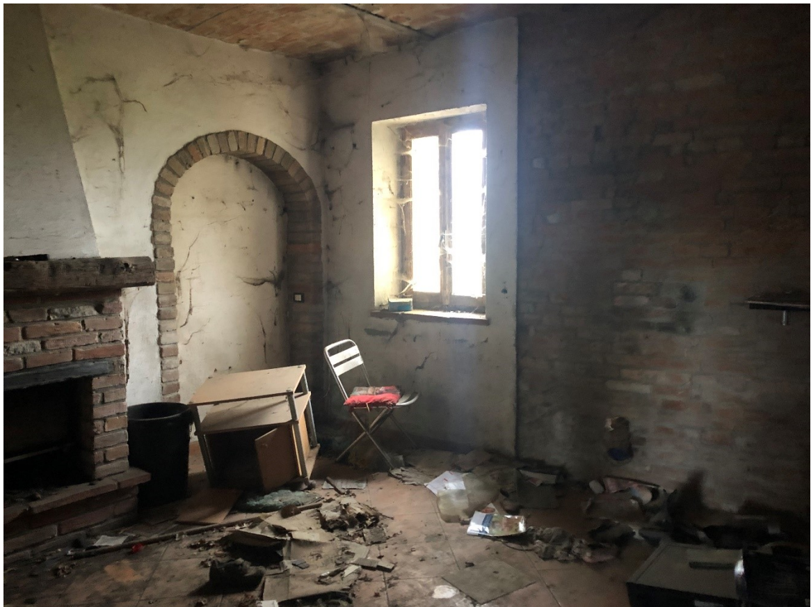
Foto n. 7 – Camera al piano terreno
