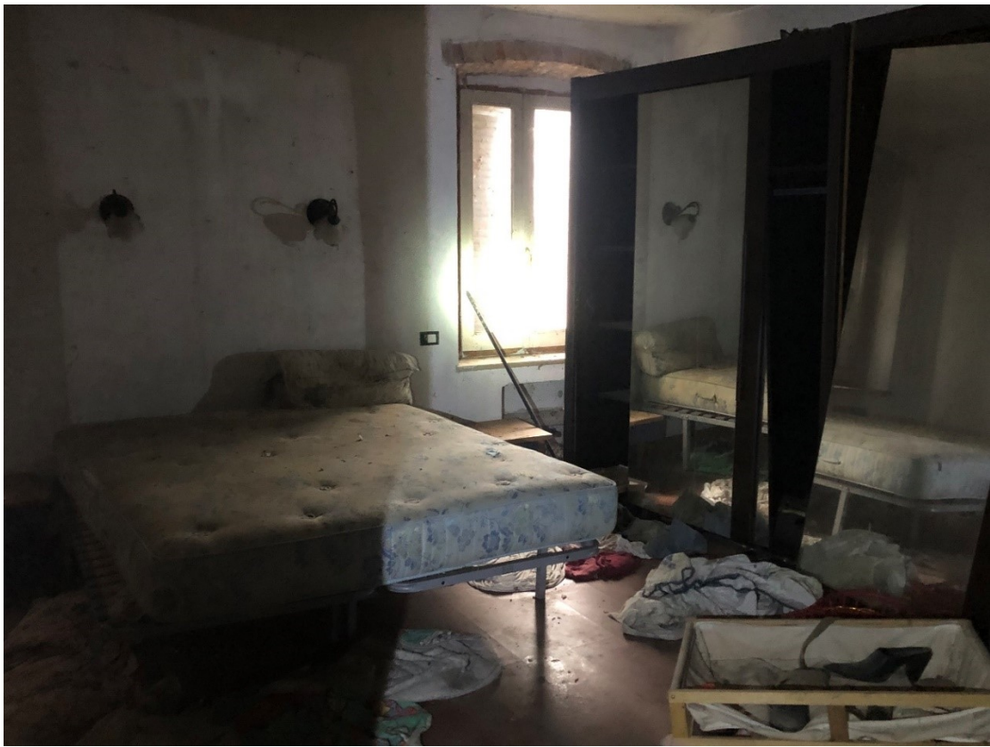
Foto n. 9 – Camera al primo piano
