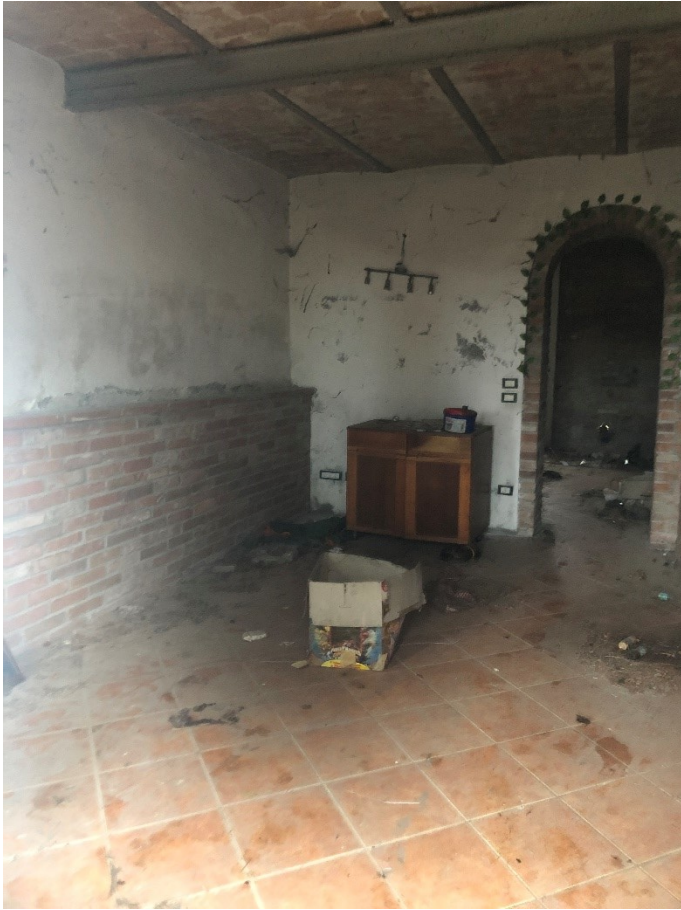
Foto n. 6 – Cucina al piano terreno
