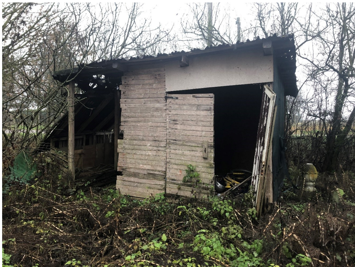
Foto n. 10 – Capanno in legno
