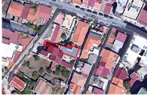
Localizzazione Immobile - vista satellitare
