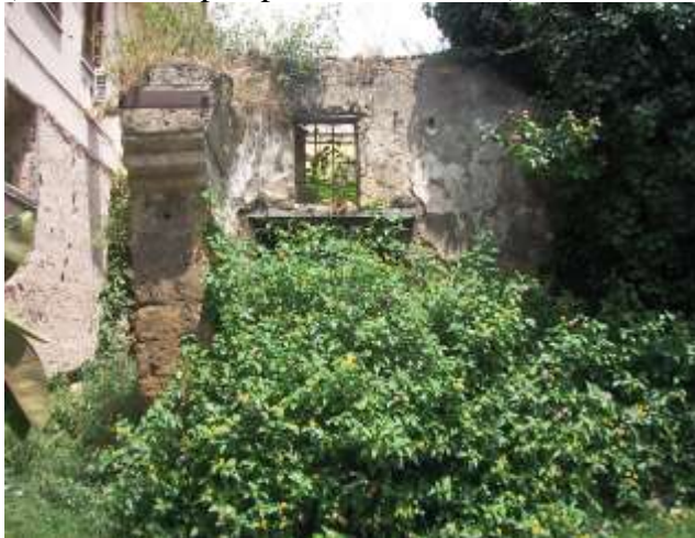
(foto 3: Vista interno corte)
