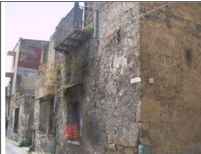
(foto 1: Vista prospettica lato strada)
