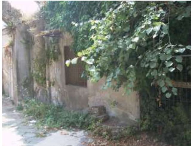
(foto 4: Vista interno corte)
