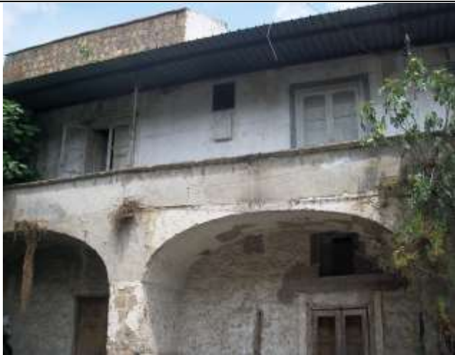
(foto 1: Vista interno corte)
