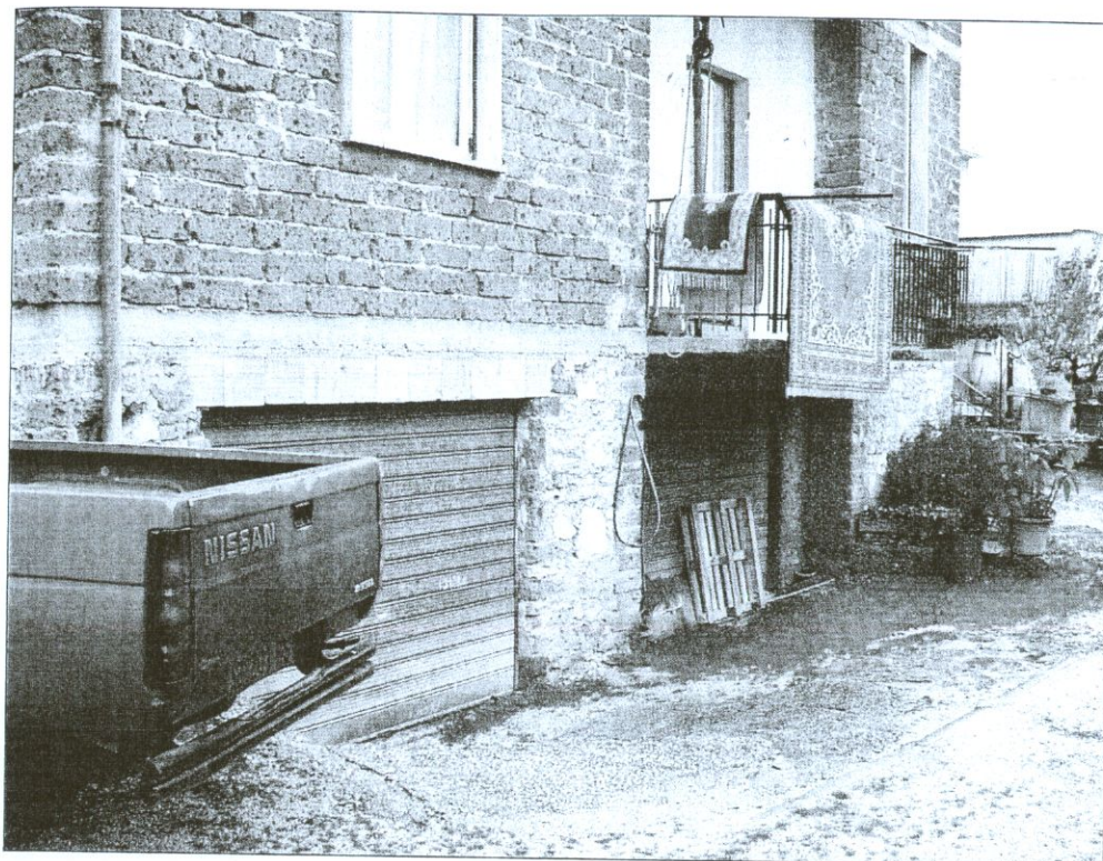
Facciata esterna lato garage
