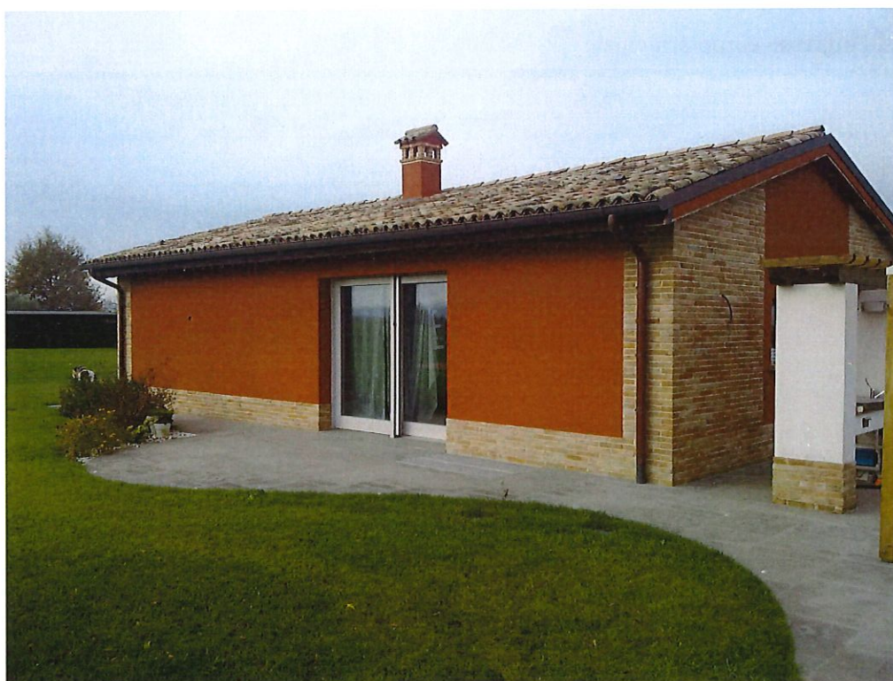
vista corpo secondario lotto B
