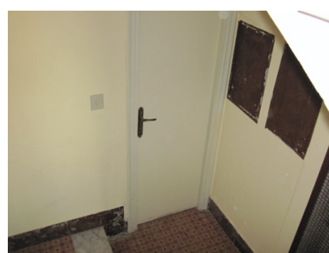
Foto 4: porta ingresso interno
