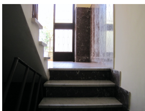
Foto 3: scala di accesso al magazzino
