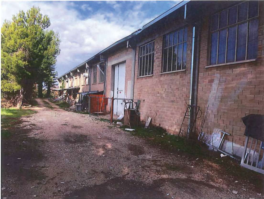
Foto n. 35 – Come foto n. 34.
