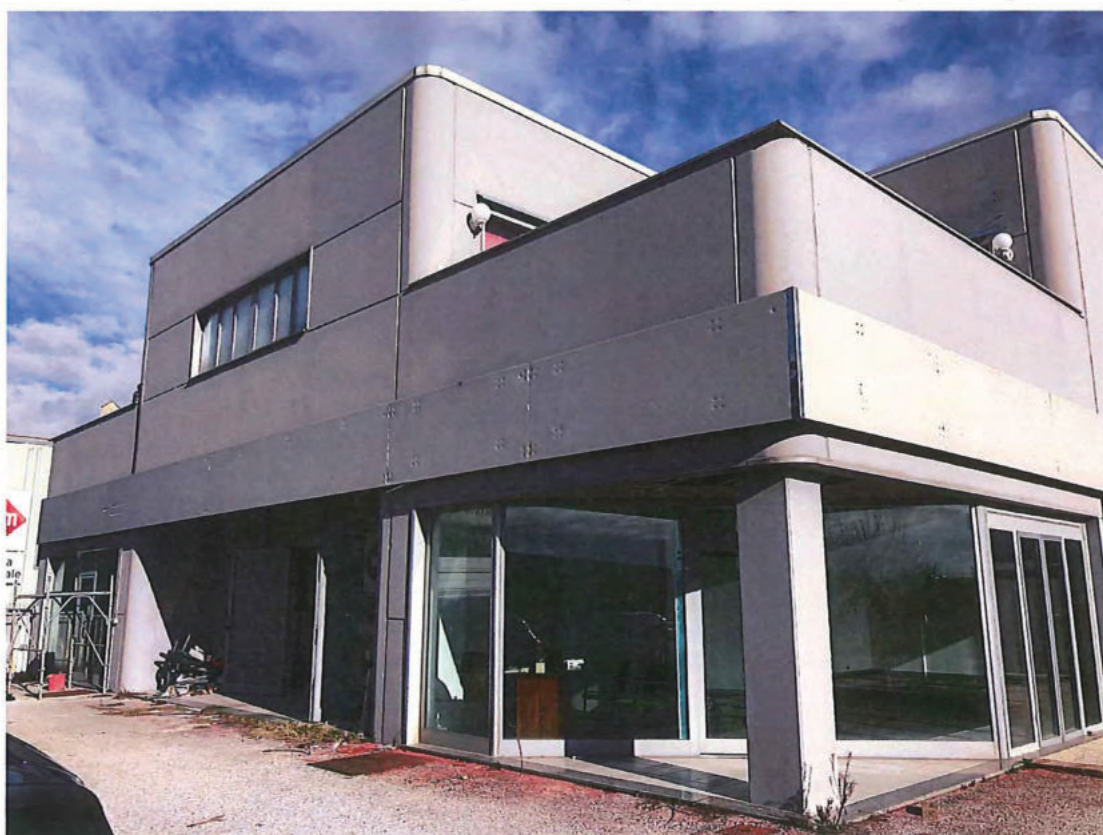
Foto n. 2 – Particolare zona ingressi piano terra (spigolo sud).
