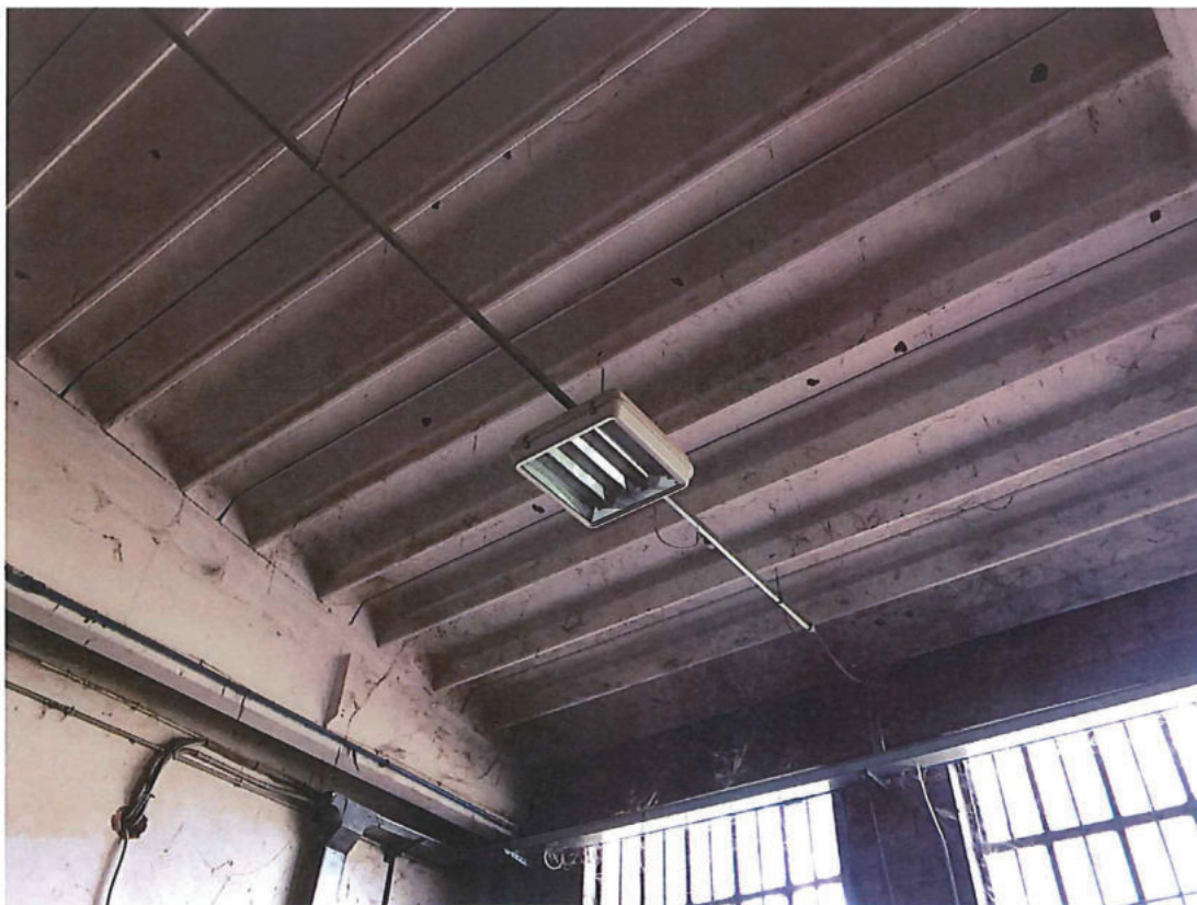
Foto n. 42 – Capannone. Particolare intradosso copertura.
