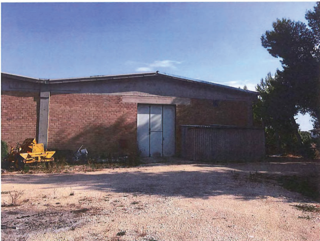
Foto n. 36 – Retrospetto (lato nord-ovest).
