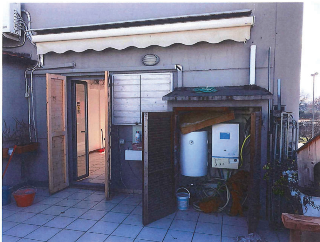
Foto n. 23 – Piano primo. Terrazzo nord-ovest.
