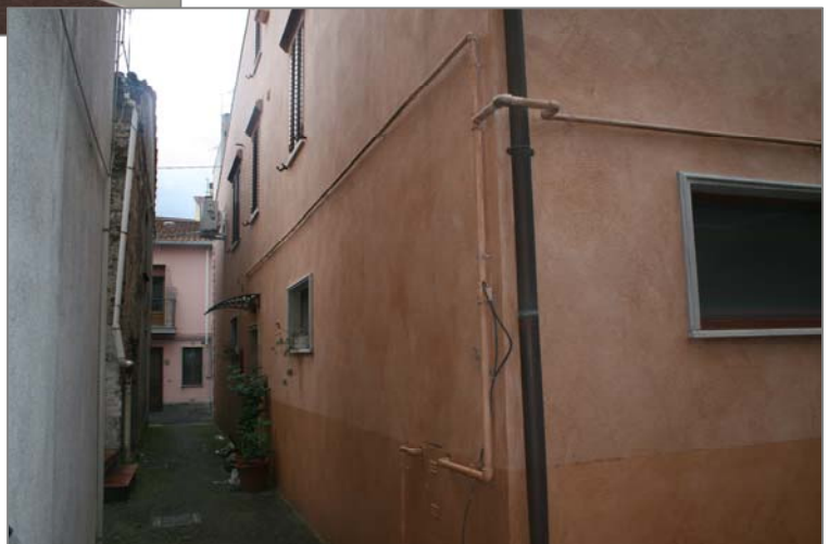
Vicolo laterale al fabbricato
