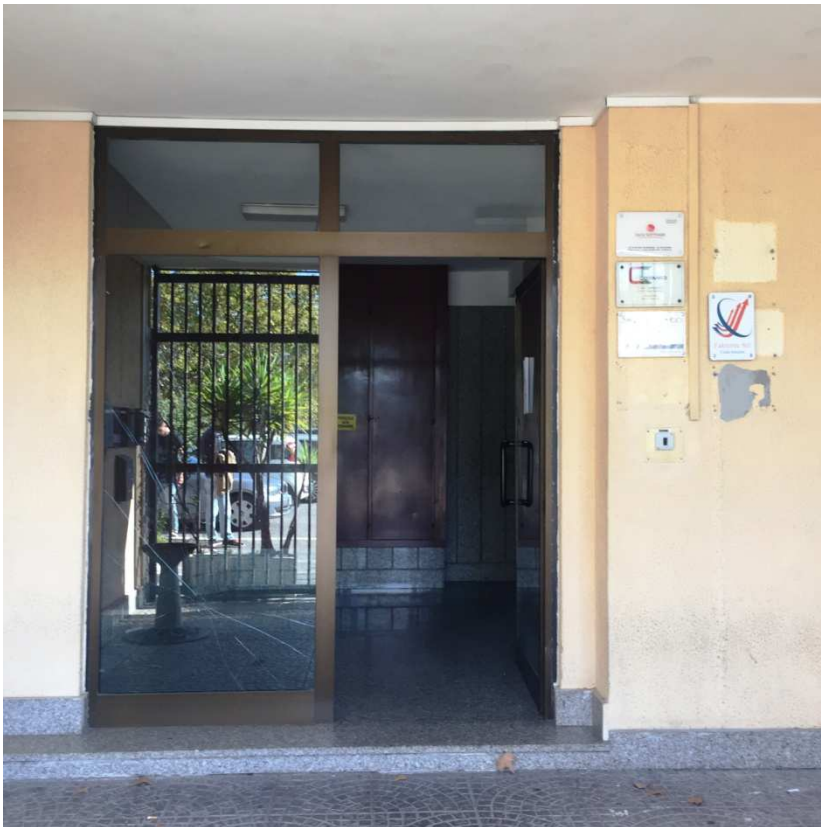
Foto 9 Ingresso al corpo scala Edificio A
