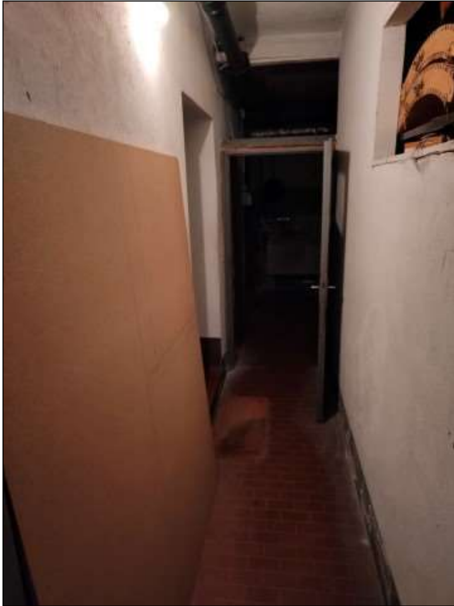
Foto n. 112 – Corridoio comune al piano interrato (B.C.N.C. Foglio 22 mappale 454 sub. 11)
