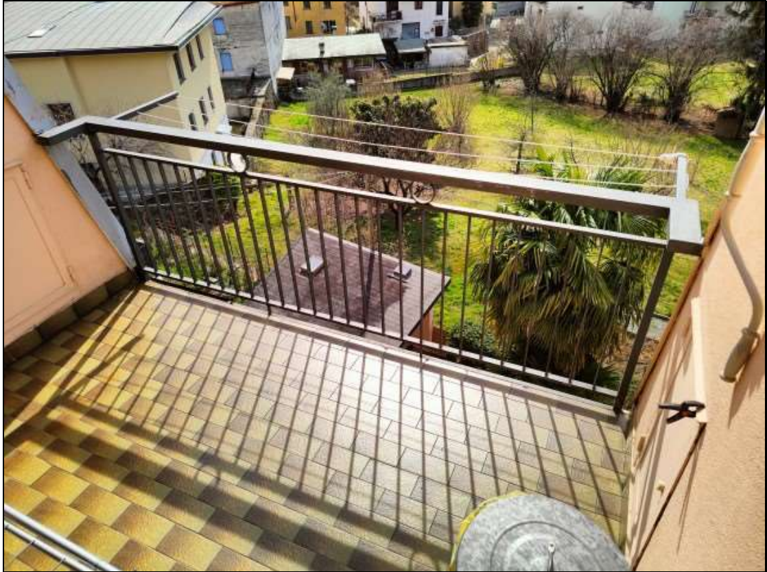
Foto n. 85 – Balcone (unità immobiliare al piano secondo/sottotetto, Foglio 22 mappale 454 sub. 4)
