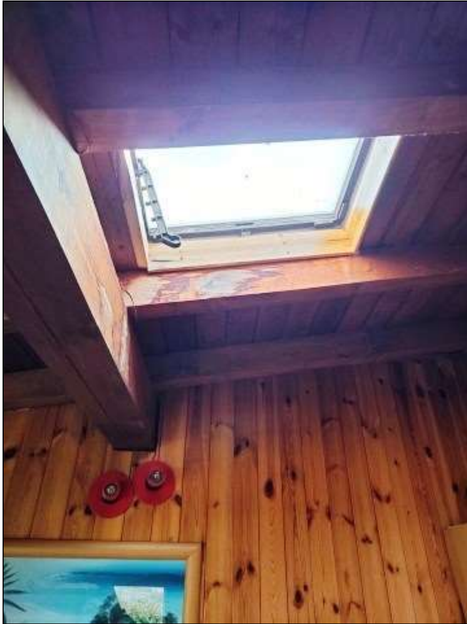
Foto n. 130 – Deposito attrezzi (Foglio 22 mappale 454 sub. 10), vista lucernario
