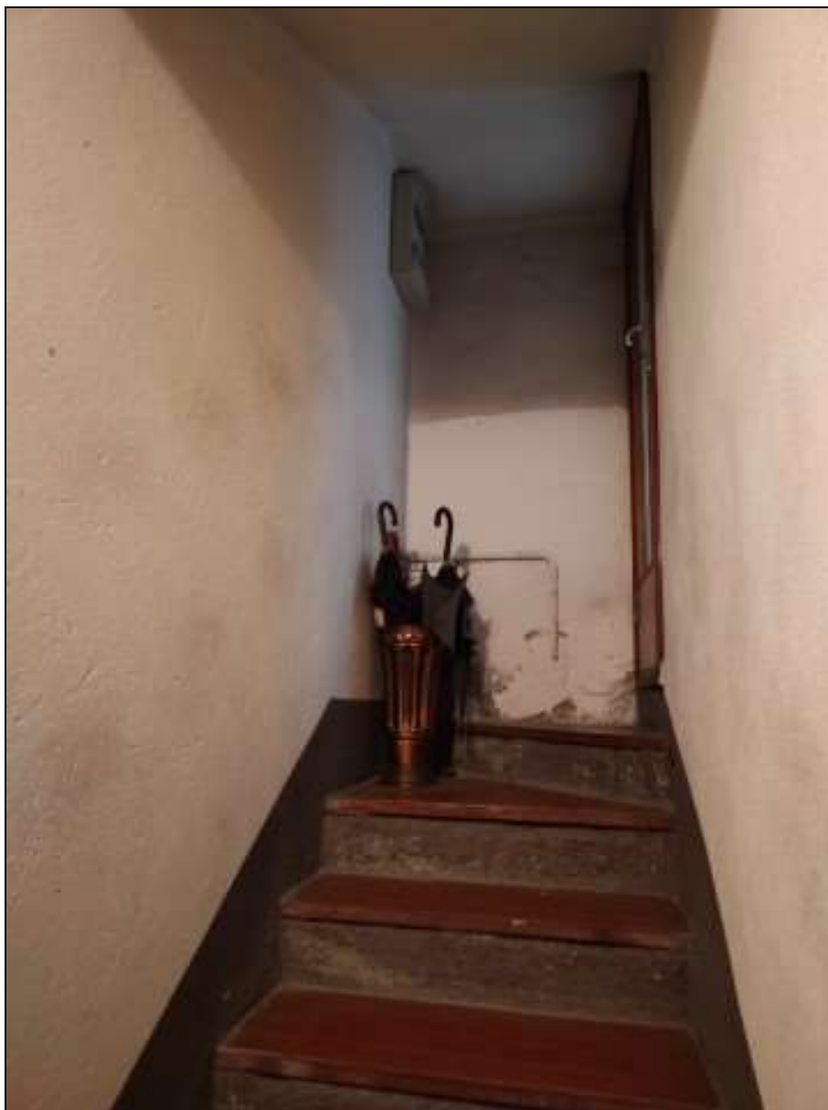
Foto n. 111 – Scala comune da piano interrato a piano terra (B.C.N.C. Foglio 22 mappale 454 sub. 11)
