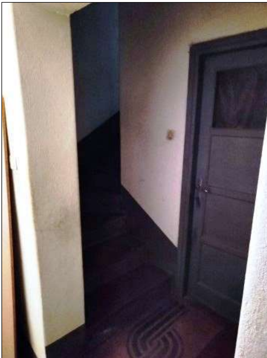
Foto n. 110 – Scala comune da piano interrato a piano terra (B.C.N.C. Foglio 22 mappale 454 sub. 11)
