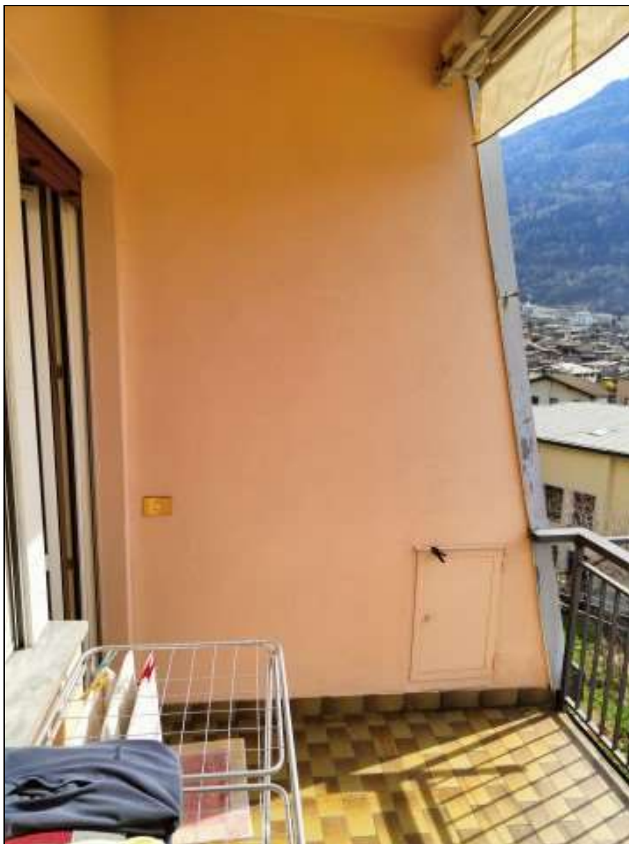
Foto n. 84 – Balcone (unità immobiliare al piano secondo/sottotetto, Foglio 22 mappale 454 sub. 4)
