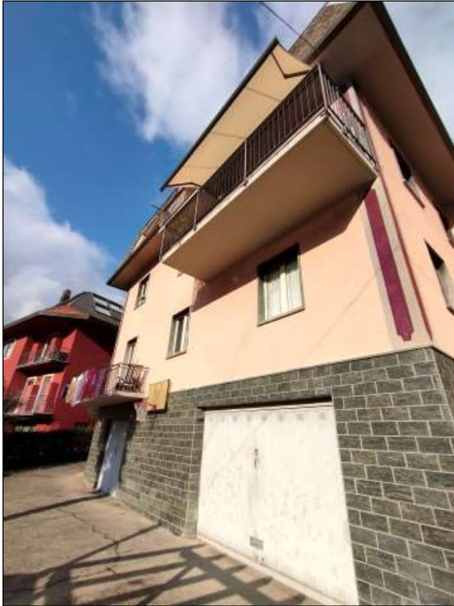
Foto n. 35 – Fabbricato residenziale, visto da sud-est
