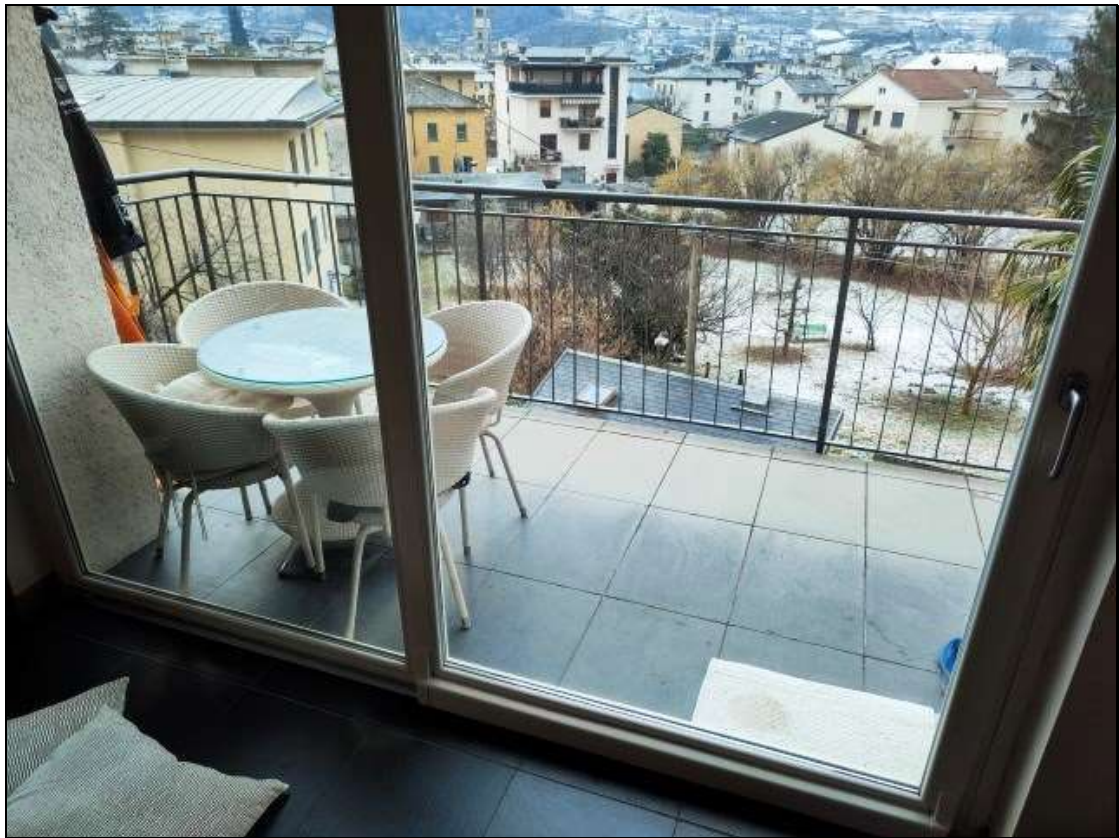
Foto n. 109 – Balcone “sud” (unità immobiliare al piano primo, Foglio 22 mappale 454 sub. 6)
