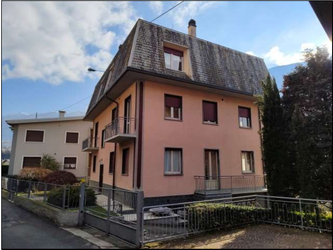
Foto n. 31 – Fabbricato residenziale, visto da nord-ovest
