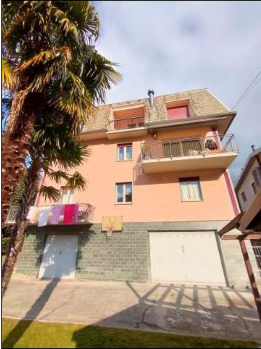
Foto n. 36 – Facciata sud del fabbricato residenziale, vista da sud
