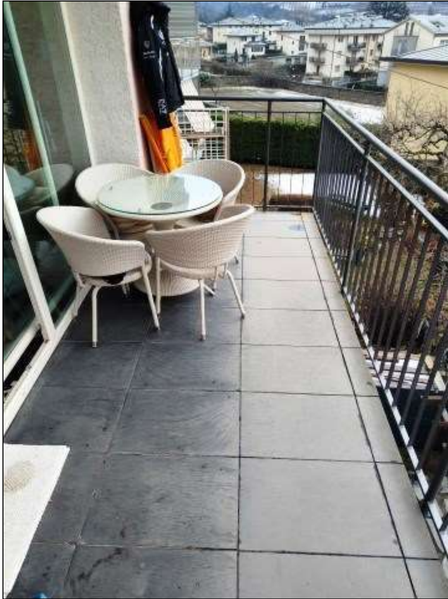
Foto n. 108 – Balcone “sud” (unità immobiliare al piano primo, Foglio 22 mappale 454 sub. 6)
