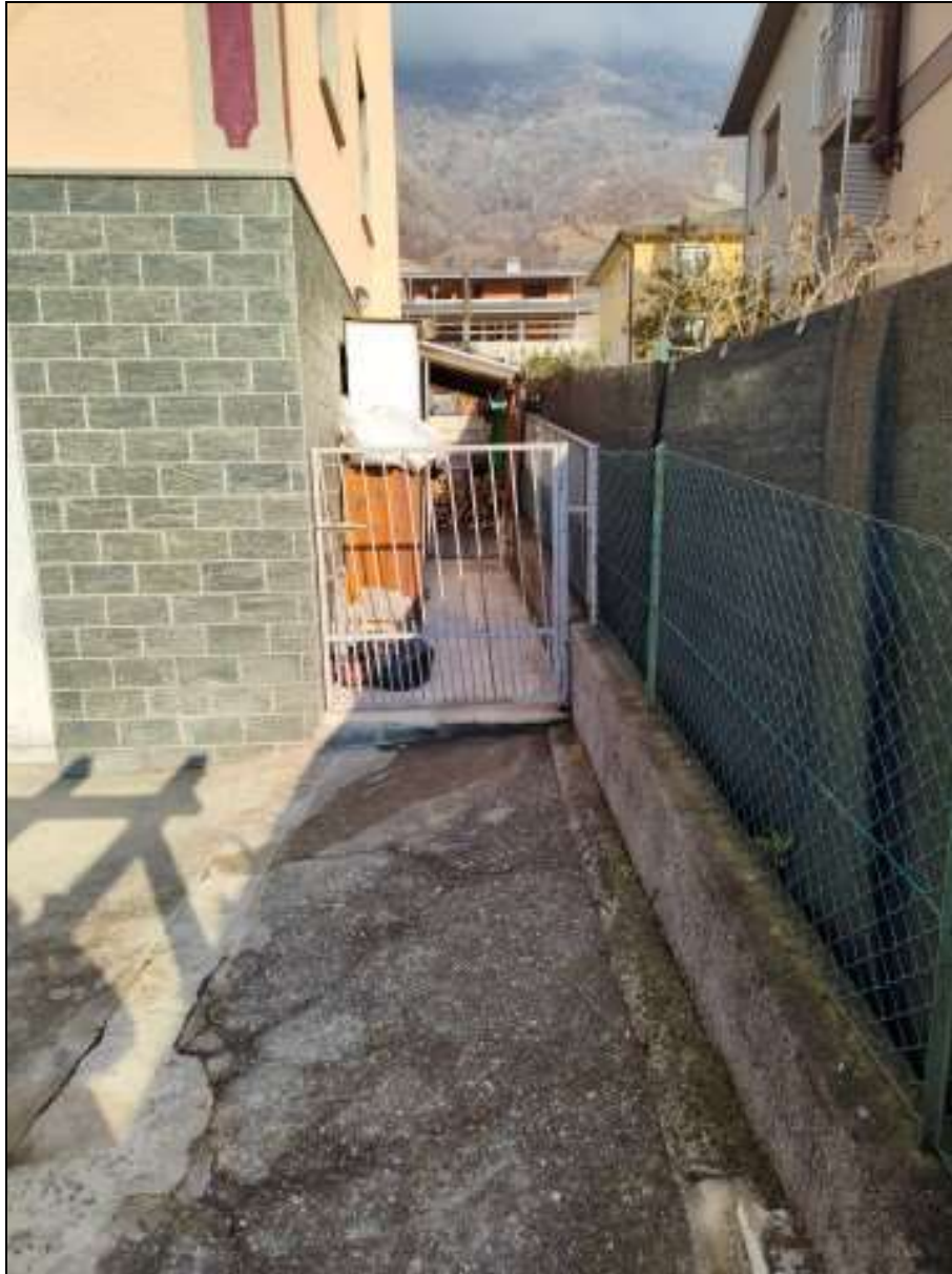
Foto n. 44 – Area comune ubicata ad est del fabbricato residenziale (B.C.N.C. Foglio 22 mappale 454 sub. 12), vista da sud
