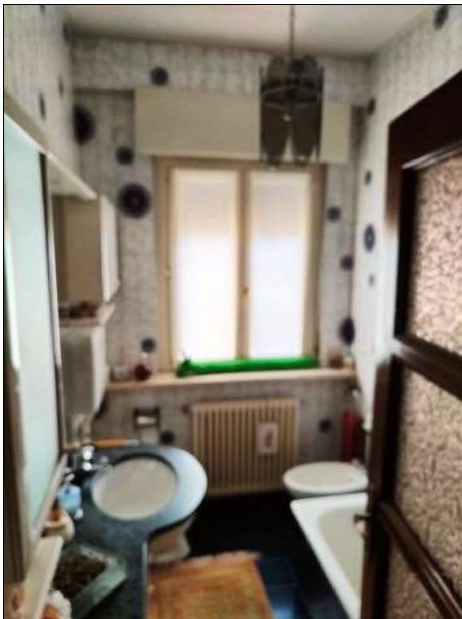
Foto n. 76 – Bagno “est” (unità immobiliare al piano secondo/sottotetto, Foglio 22 mappale 454 sub. 4)
