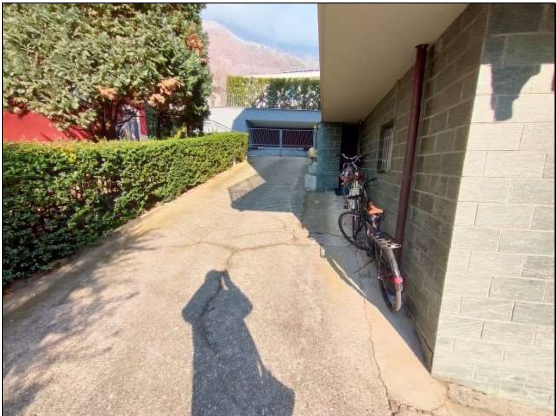
Foto n. 41 – Area comune destinata a rampa carrabile ubicata ad ovest del fabbricato residenziale (B.C.N.C. Foglio 22 mappale 454 sub. 12), vista da sud
