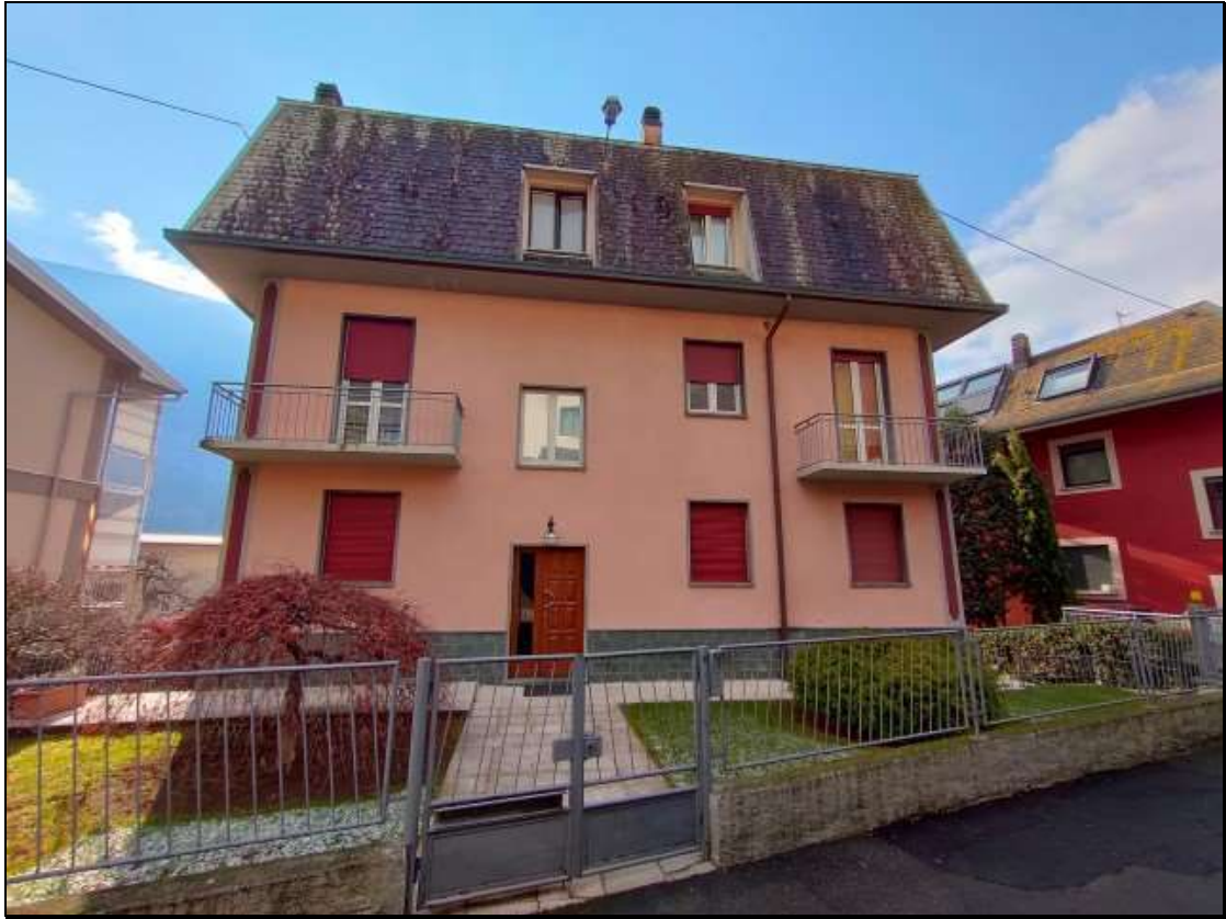
Foto n. 33 – Facciata nord del fabbricato residenziale, vista da nord
