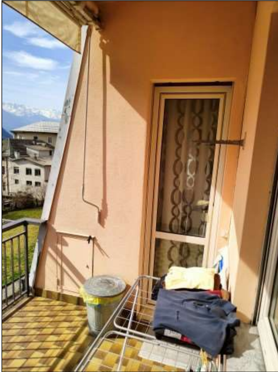
Foto n. 82 – Balcone (unità immobiliare al piano secondo/sottotetto, Foglio 22 mappale 454 sub. 4)
