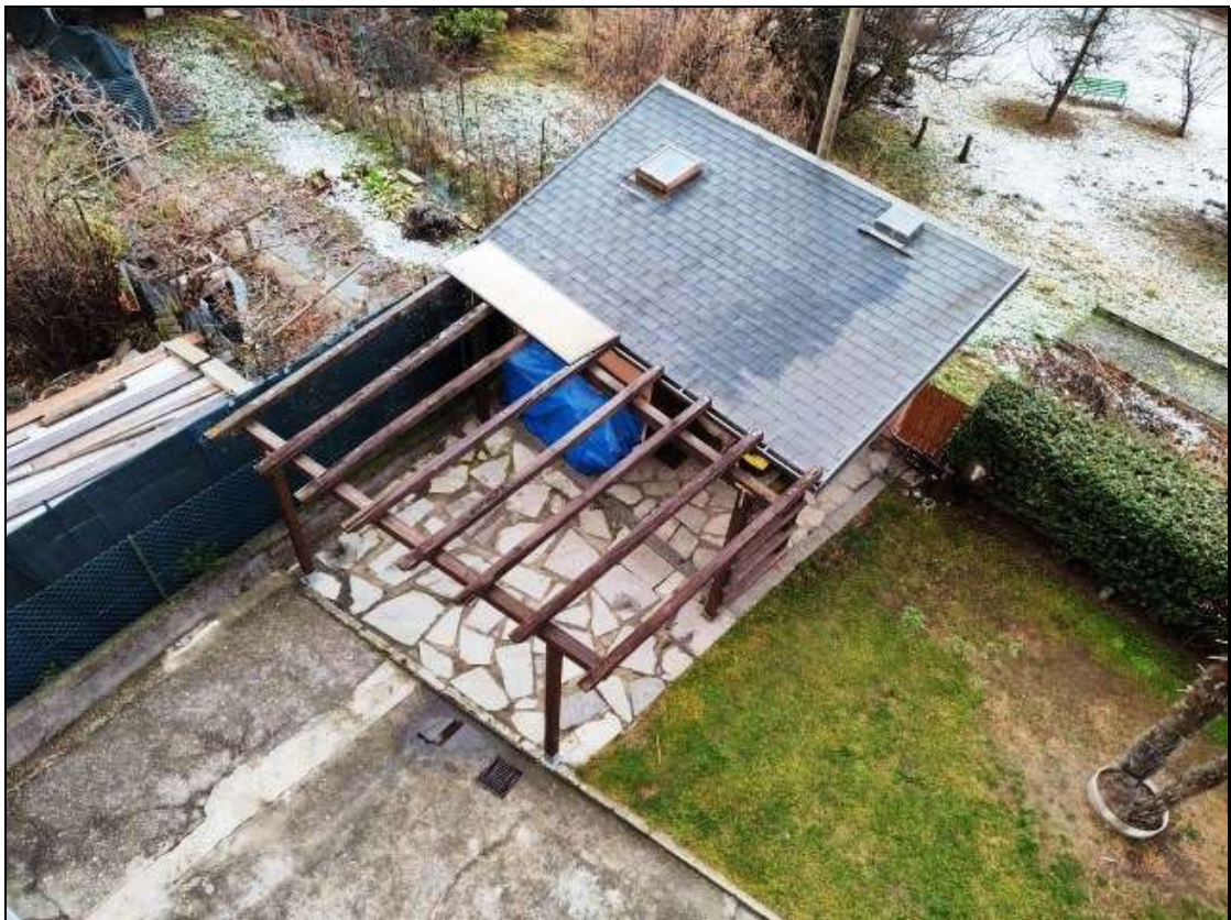
Foto n. 125 – Deposito attrezzi in corpo staccato e relativa area di pertinenza esclusiva (Foglio 22 mappale 454 subb. 10 e 13), visti da nord-ovest (vista dall'alto)
