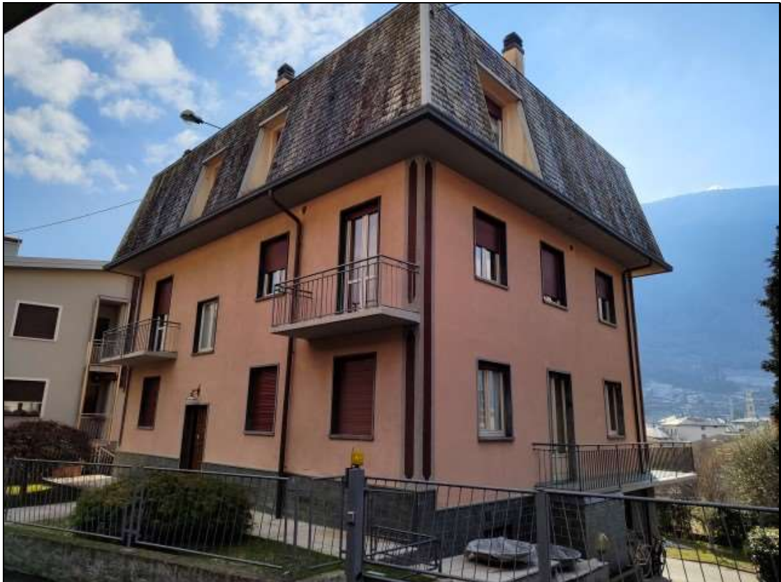
Foto n. 32 – Fabbricato residenziale, visto da nord-ovest
