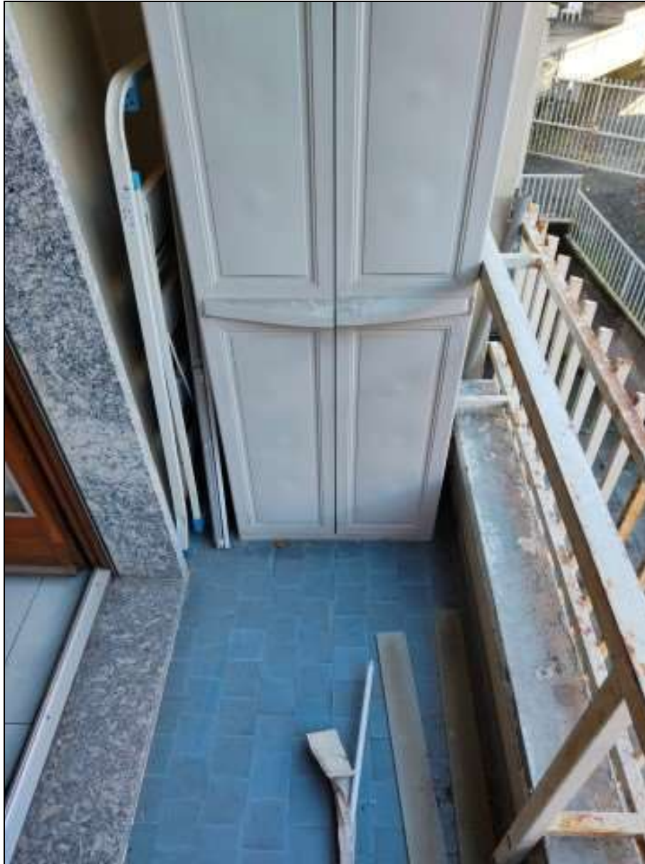
Foto n. 27 – Balcone “nord” al piano primo (unità immobiliare Foglio 33 mappale 113 sub. 10)
