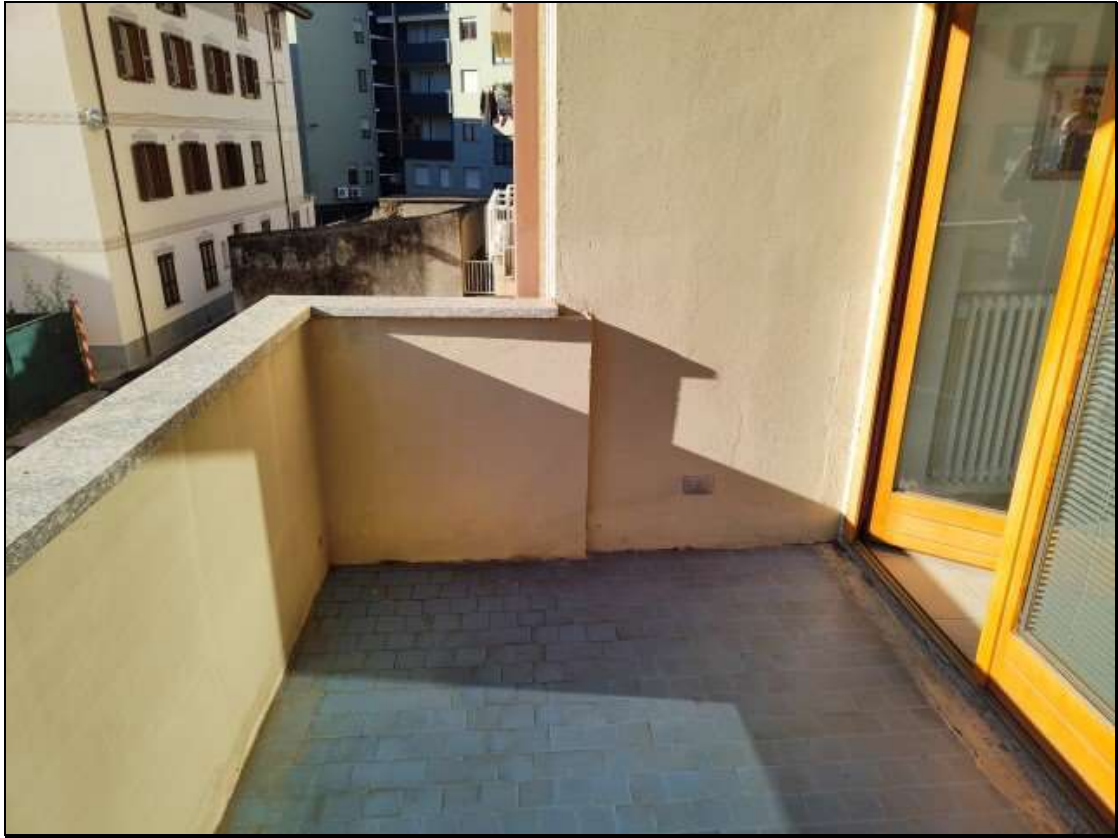
Foto n. 29 – Balcone “sud” al piano primo (unità immobiliare Foglio 33 mappale 113 sub. 10)
