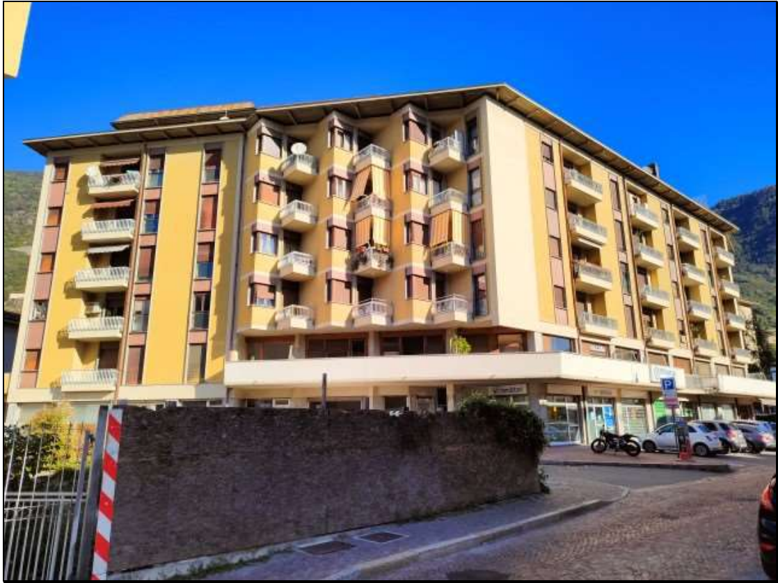
Foto n. 1 – Fabbricato Foglio 33 mappale 113, denominato “Condominio dei Cedri”, visto da sud-est
