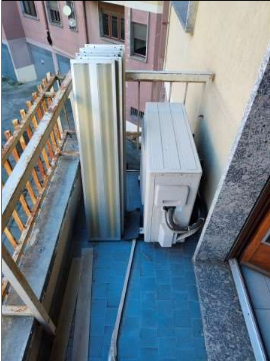
Foto n. 28 – Balcone “nord” al piano primo (unità immobiliare Foglio 33 mappale 113 sub. 10)
