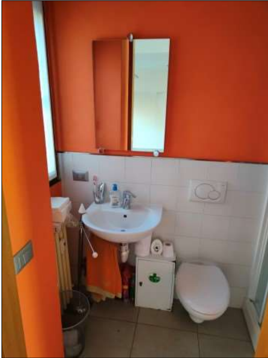
Foto n. 24 – Bagno al piano primo (unità immobiliare Foglio 33 mappale 113 sub. 10)
