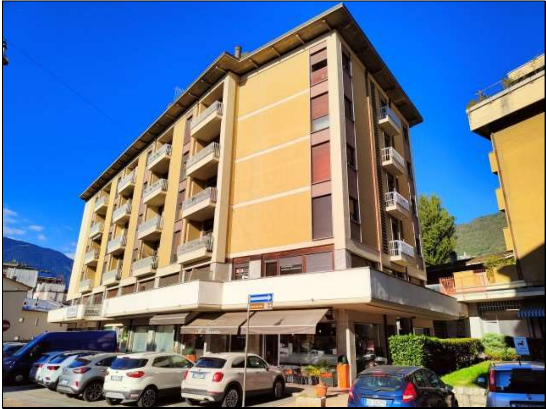
Foto n. 3 – Fabbricato Foglio 33 mappale 113, denominato “Condominio dei Cedri”, visto da nord-est
