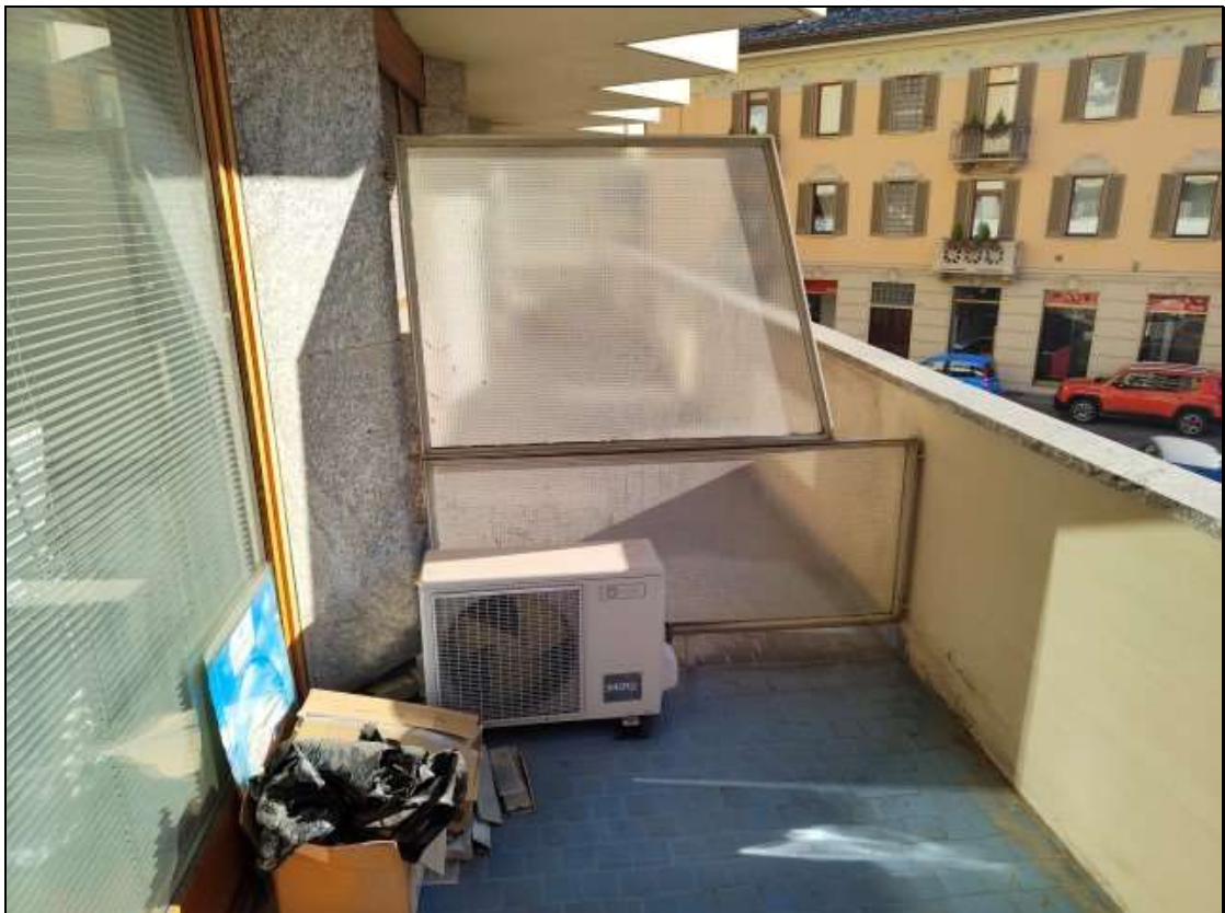
Foto n. 30 – Balcone “sud” al piano primo (unità immobiliare Foglio 33 mappale 113 sub. 10)
