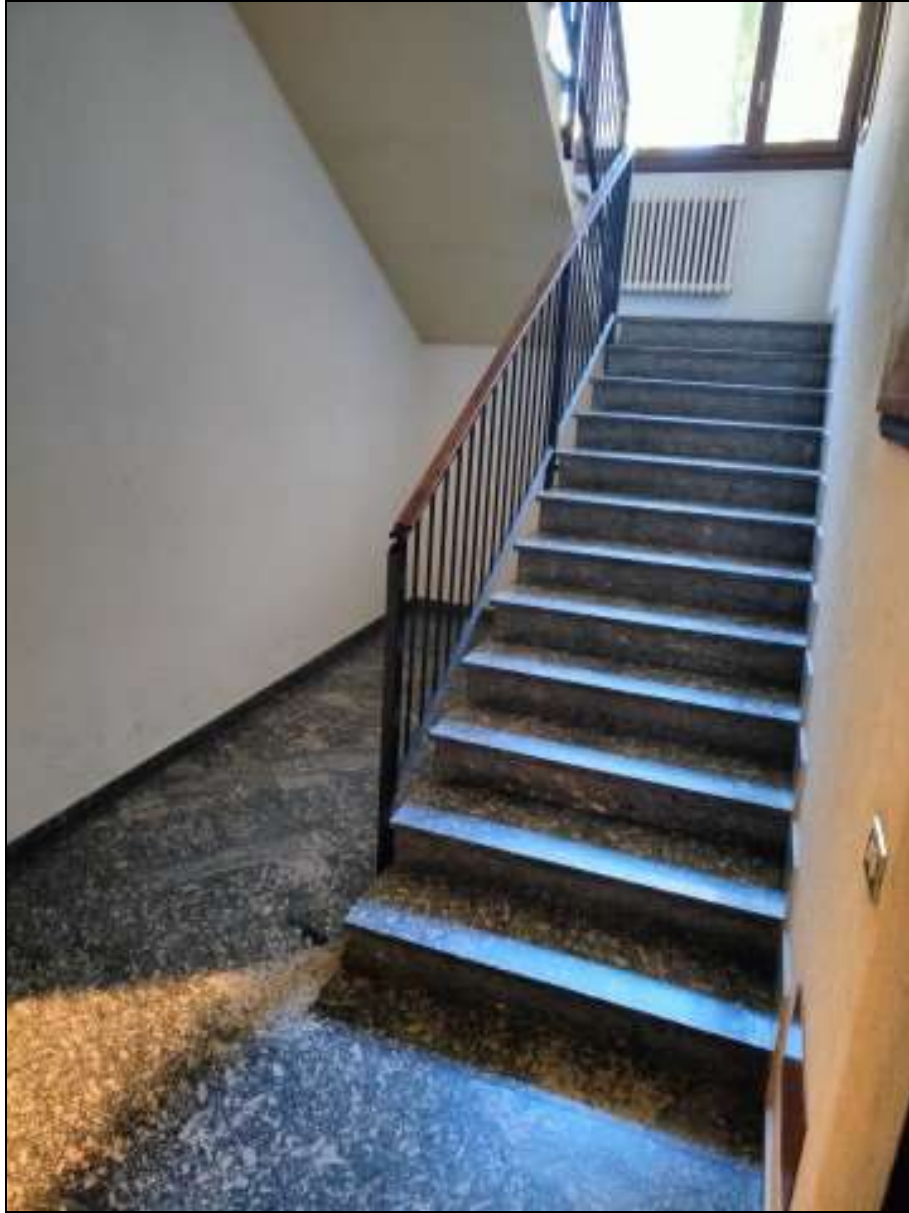
Foto n. 8 – Scala condominiale vista dal pianerottolo al piano terra
