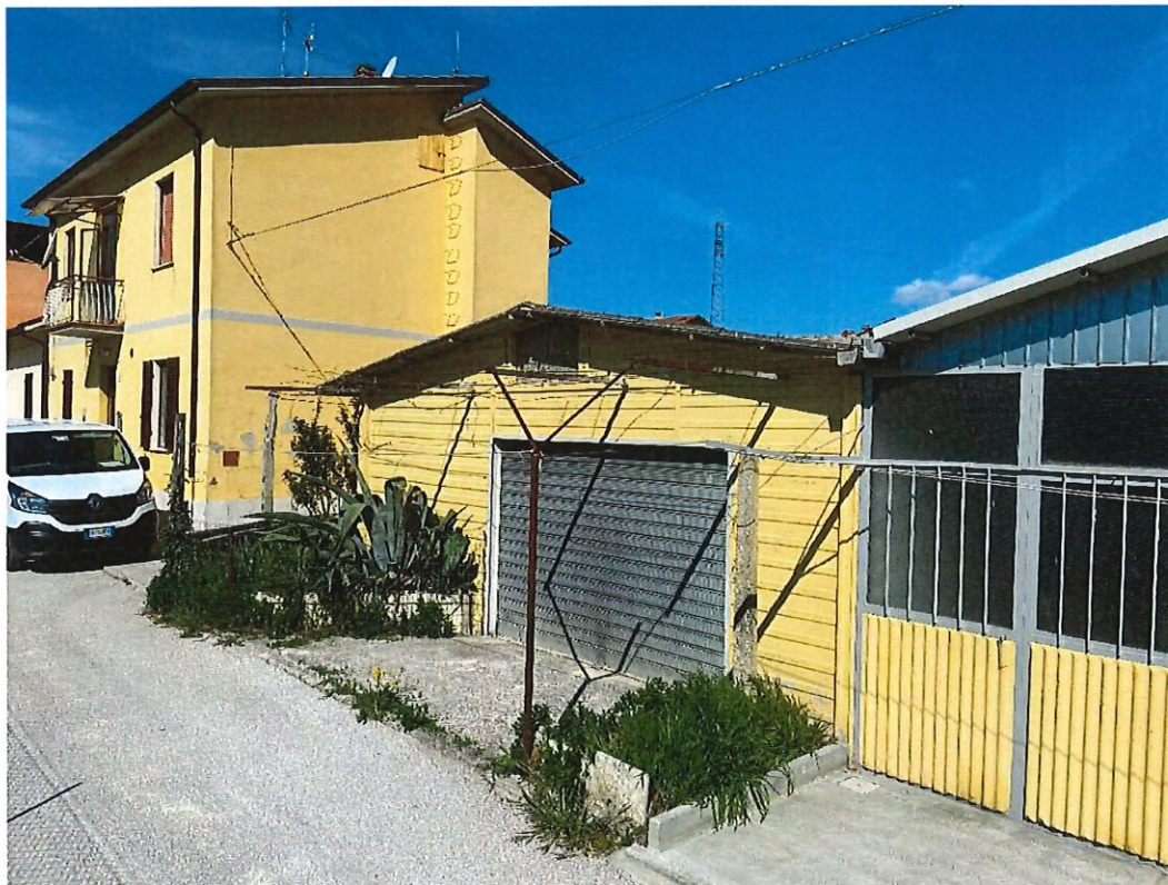
Foto n.2 - foto esterna lato garage e abitazione
