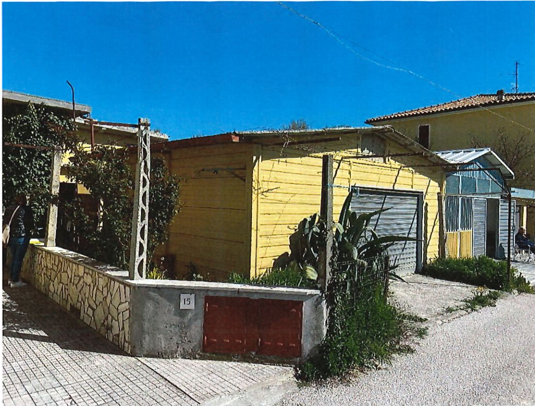
Foto n.1 - foto esterna lato garage e ripostiglio
