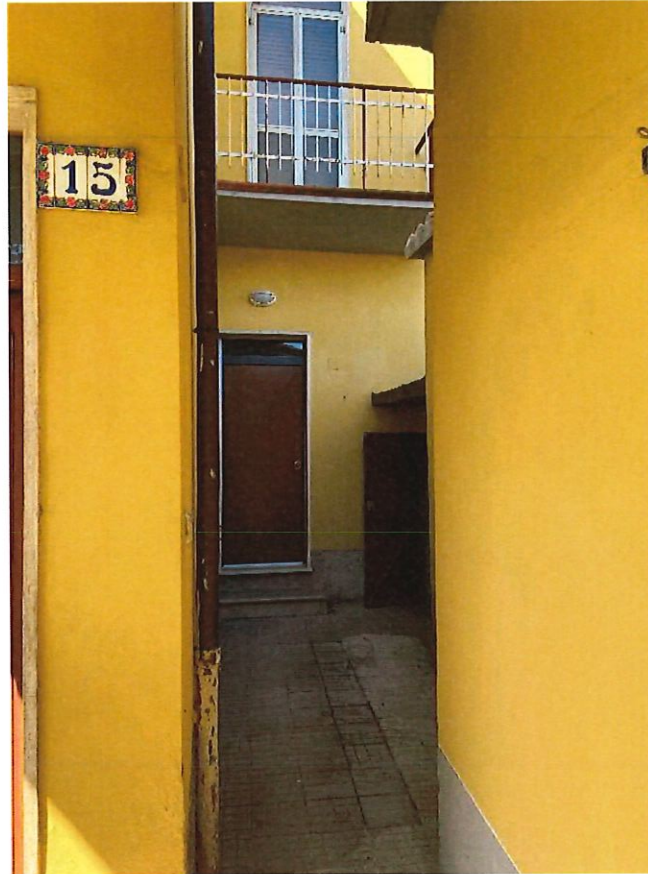
Foto n.5 - foto esterna lato serbatoio e c.t.
