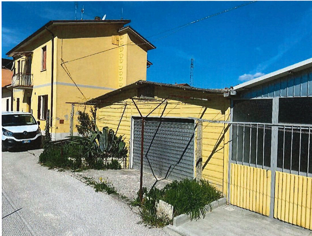
Foto n.2 - foto esterna lato garage e abitazione
