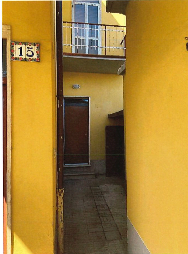
Foto n.5 - foto esterna lato serbatoio e c.t.
