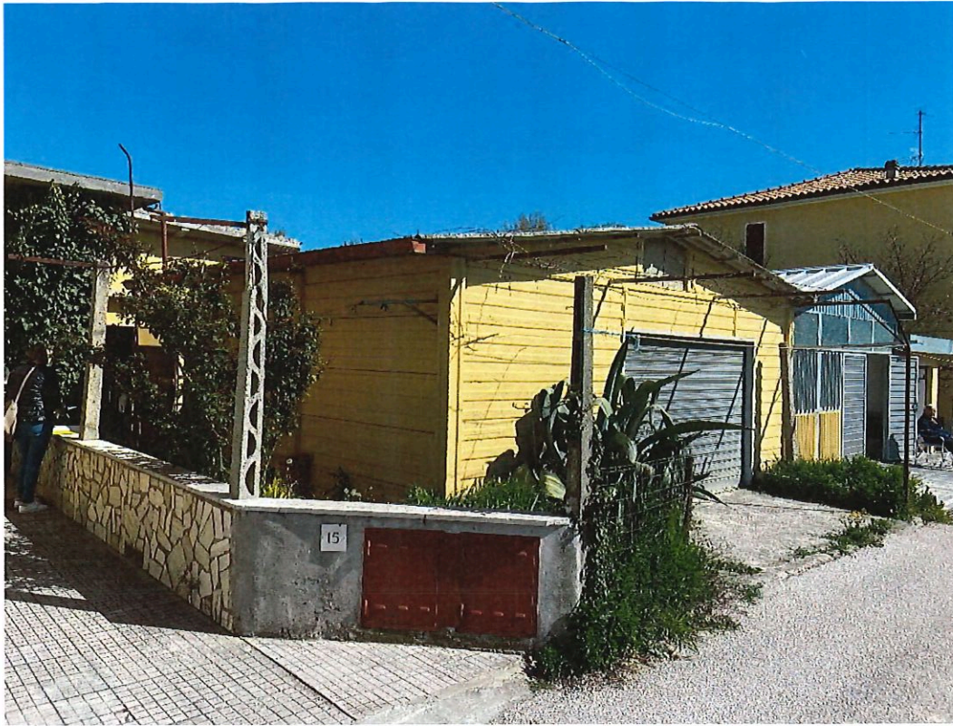
Foto n.1 - foto esterna lato garage e ripostiglio
