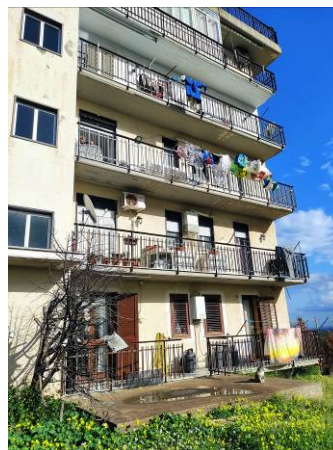
Foto 2,3,4. Fabbricato in cui è sito l'immobile
