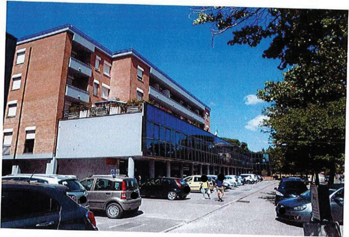
Vista complessiva fabbricato
