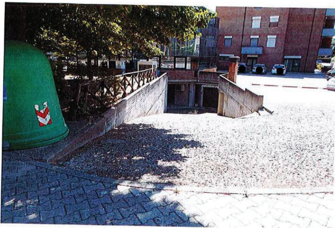
Ingresso rampa di accesso alla palestra
