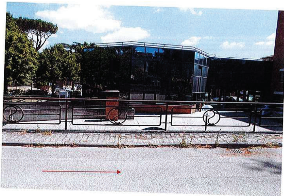
Vista complessiva fabbricato lato fianco
