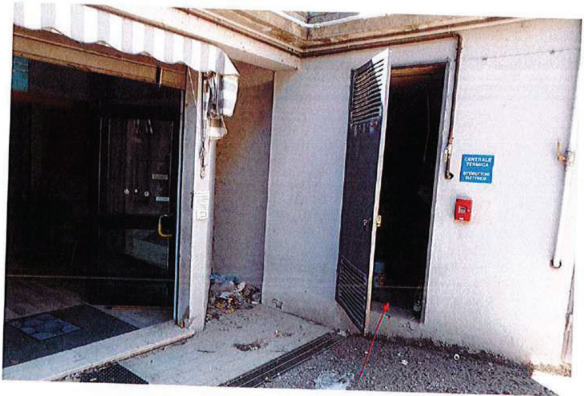
Ingresso Centrale Termica
