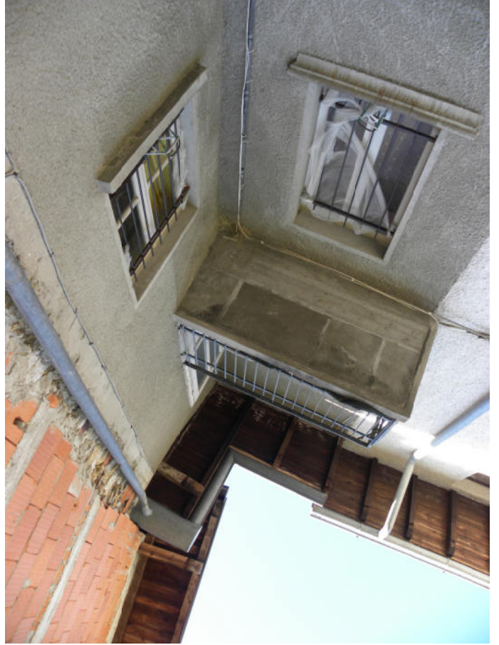
ESTERNO ANGOLO SUD EST
