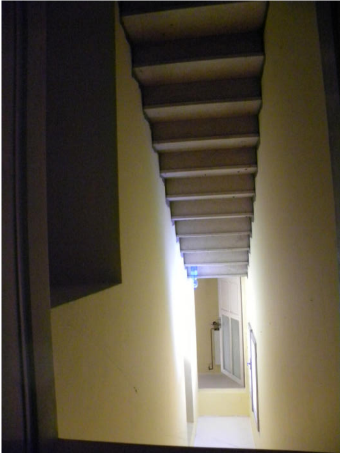
SCALA AL PIANO PRIMO
