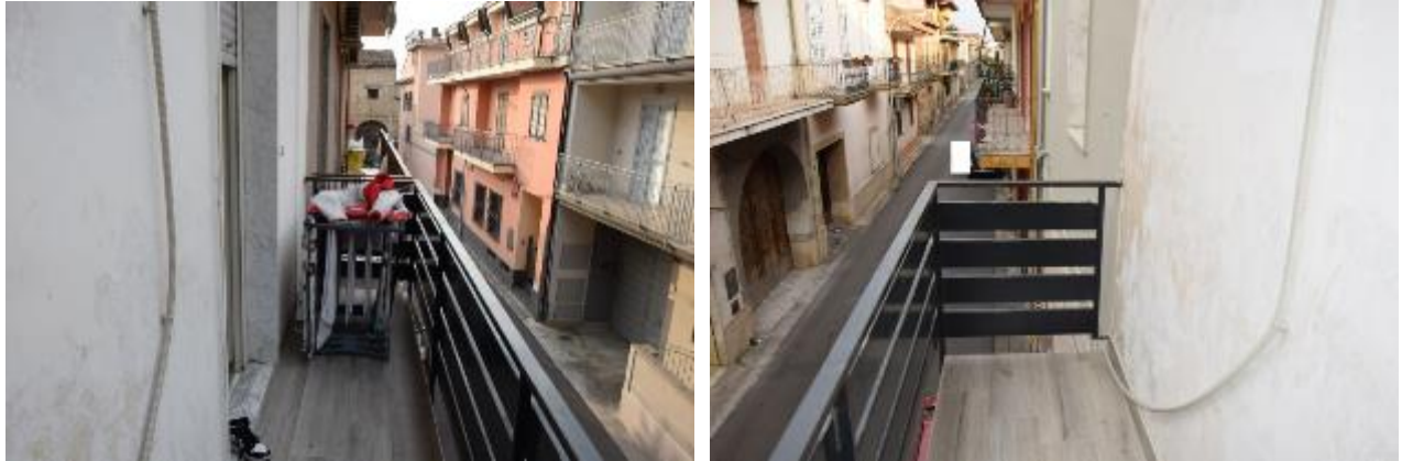
Vista esterna dell'appartamento (sub. 9)
