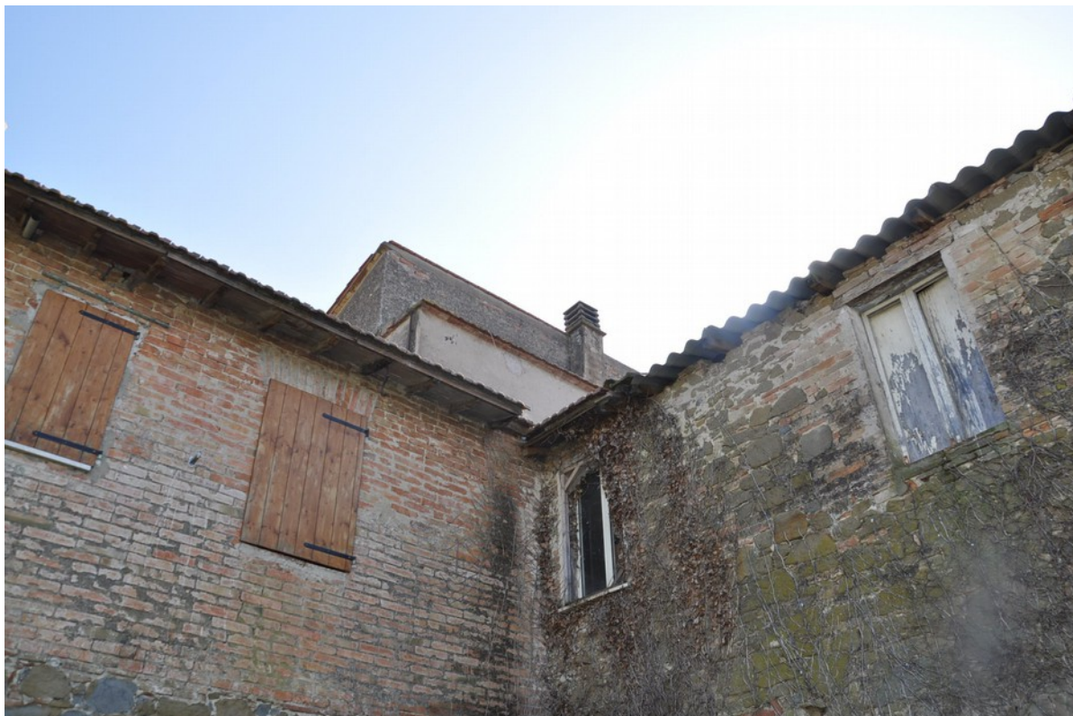
FOTO 4 PROSPETTO POSTERIORE PARTICOLARE COPERTURA
