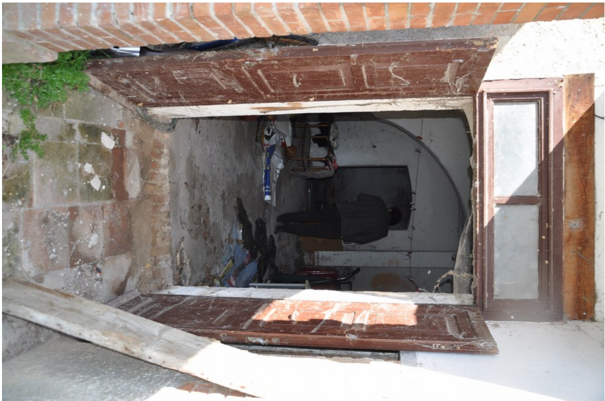
FOTO 6 INGRESSO PIANO TERRA
