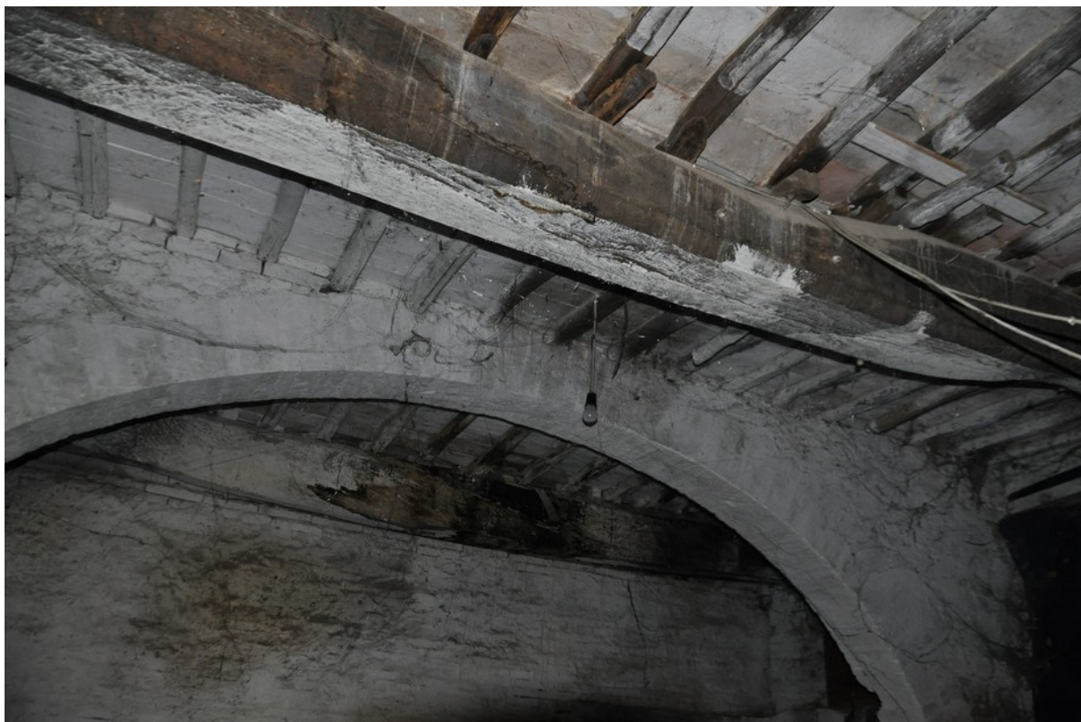
FOTO 11 P.T. SOFFITTO VISTA SOLAIO IN LEGNO
