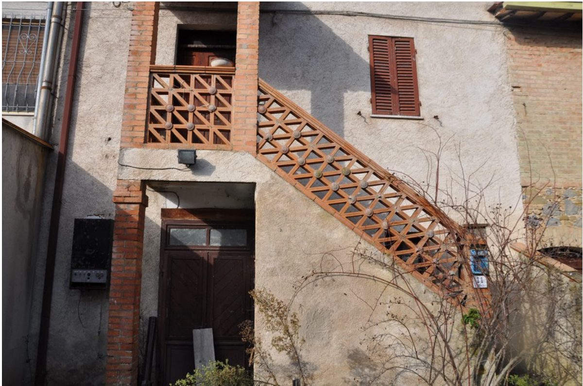
FOTO 5 PROS. ANTERIORE PART. INGRESSO PIANO TERRA E PRIMO
