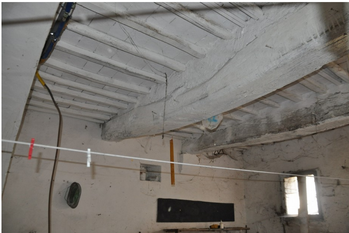
FOTO 9 P.T. SOFFITTO VISTA SOLAIO IN LEGNO
