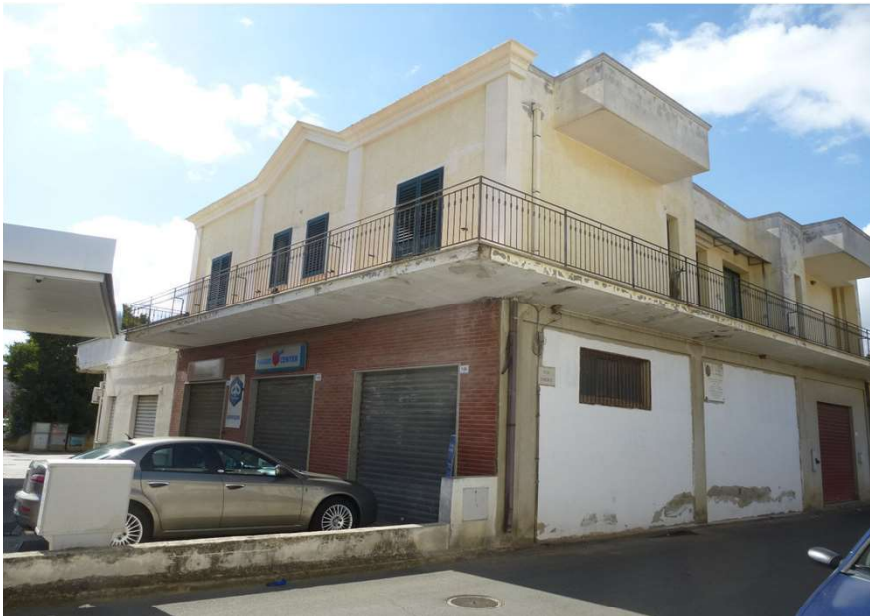
fotografia n° 2 vista del fabbricato dalla via Omero
