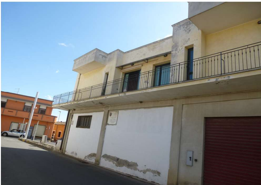
fotografia n° 3 altra vista del fabbricato dalla via Omero
