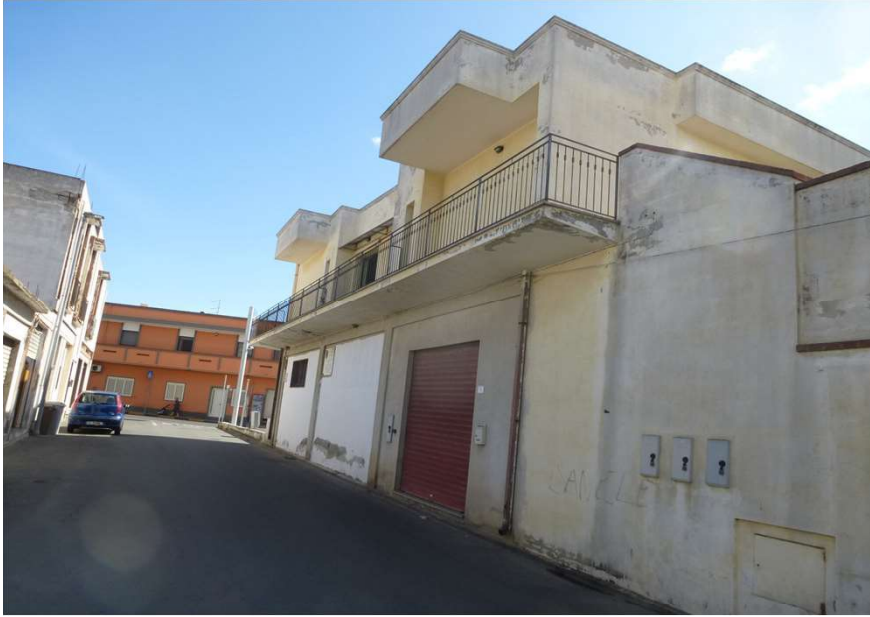
fotografia n° 4 altra vista del fabbricato dalla via Omero
