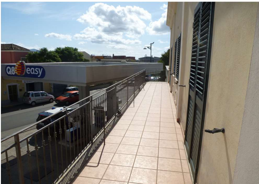
fotografia n° 14 vista balcone alla via Nazionale in aderenza alla stazione di servizio
