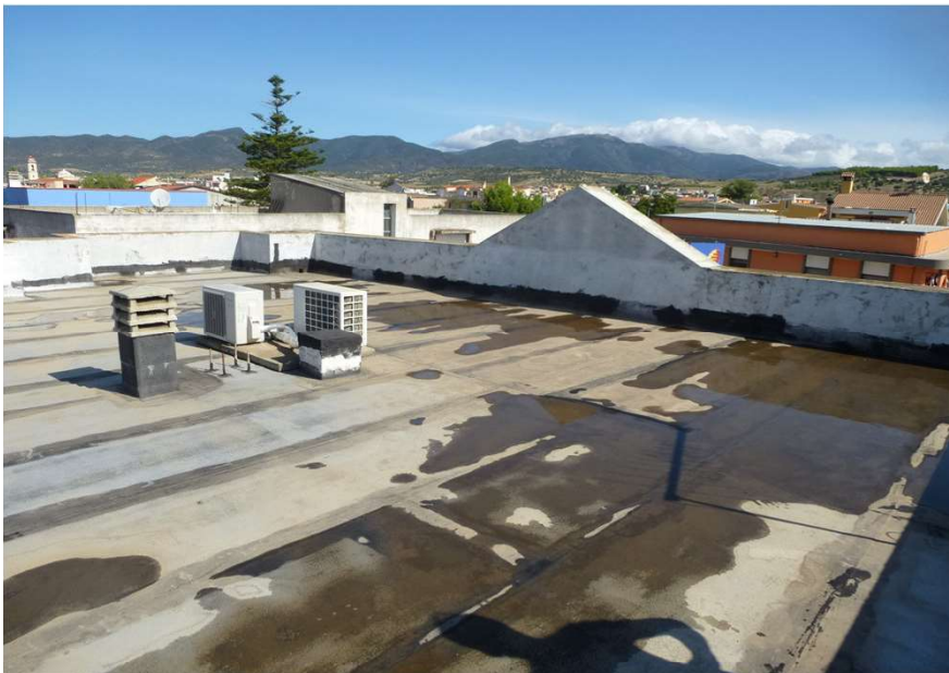
fotografia n° 37 vista copertura appartamento
