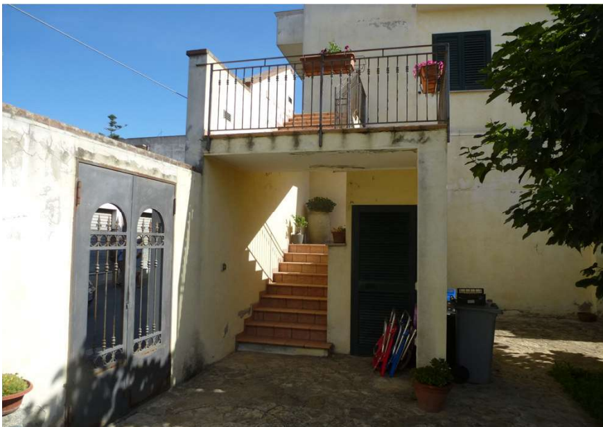
fotografia n° 6 vista scala esterna dall'area cortilizia
