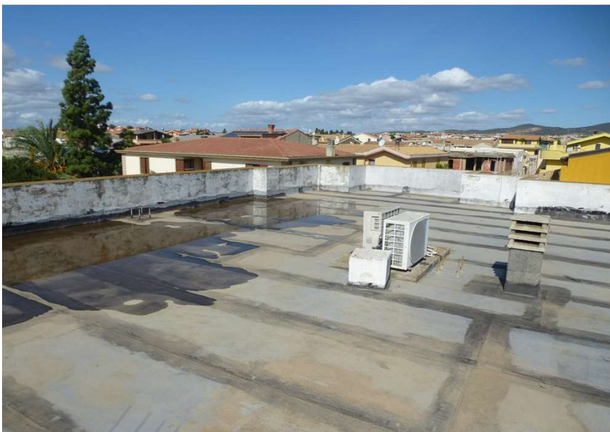
fotografia n° 38 altra vista copertura appartamento
