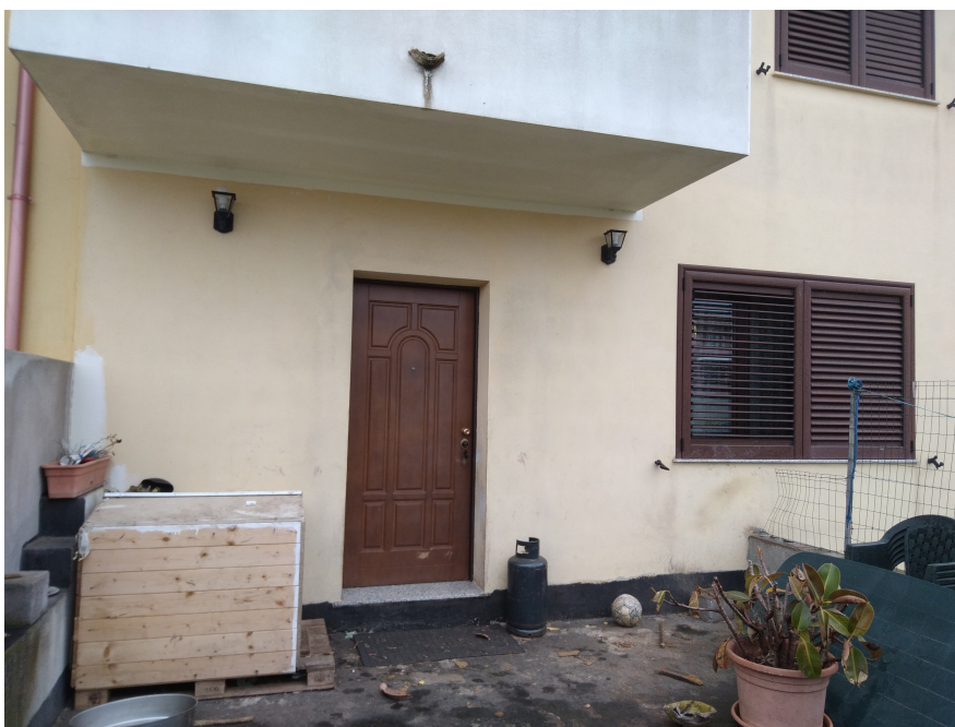
Figura 3 ingresso piano terra
