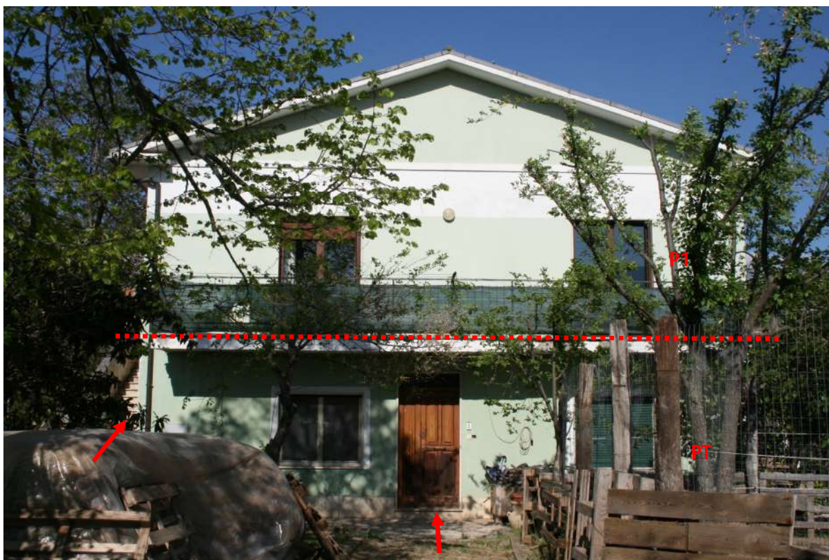
Fronte principale d'ingresso del fabbricato
