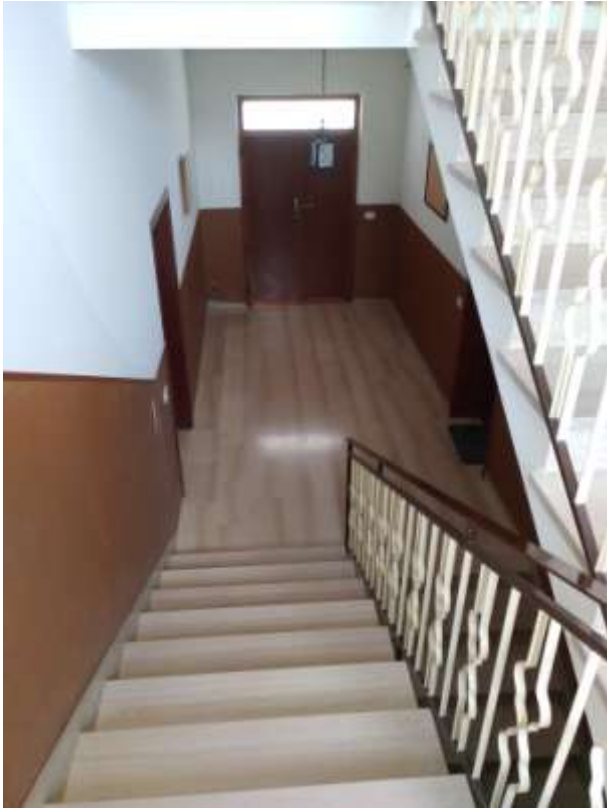
ANDRONE E SCALA CONDOMINIALE
