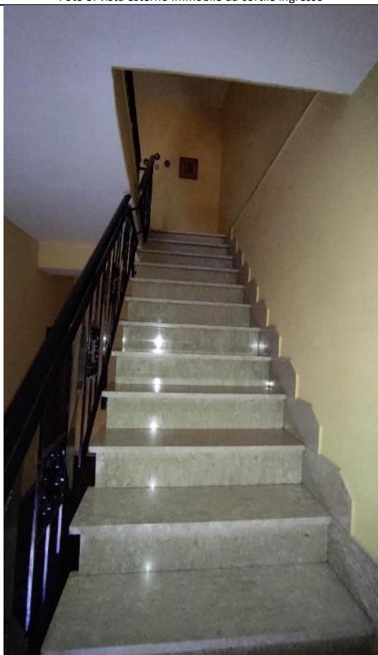
Foto 5: vista interno scale di accesso
