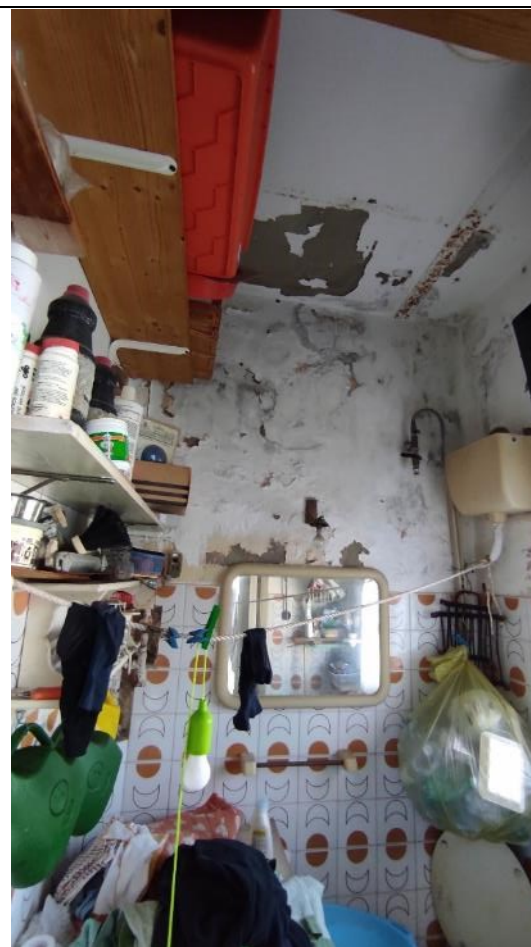
Foto 22: vista lavatoio su balcone
