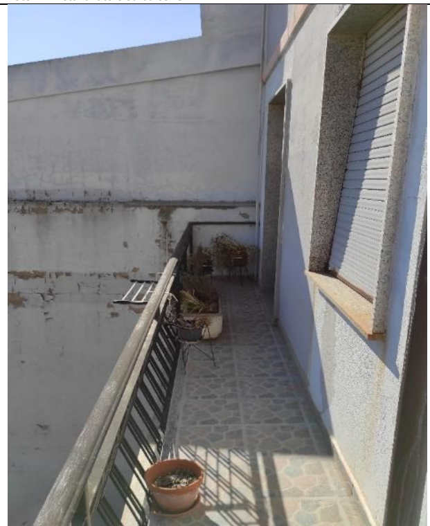
Foto 24: vista balcone su via Toti
