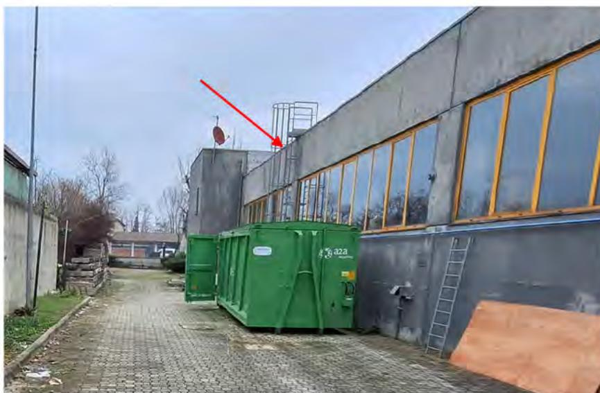
Figura 29: ripresa fotografica della scala esterna per accedere alla copertura
