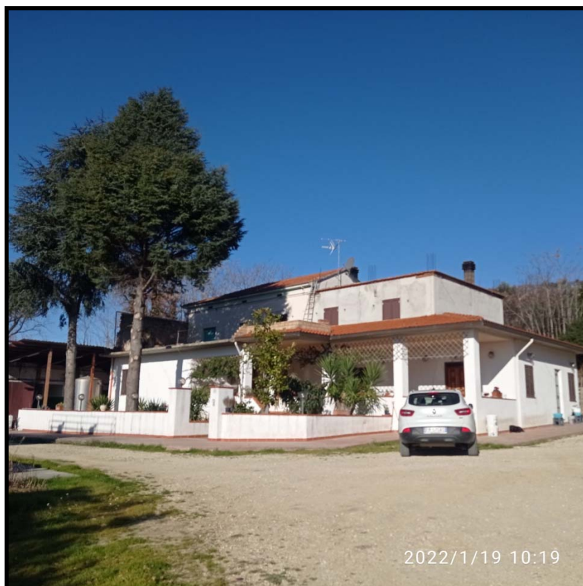
FOTO 5 – IMMOBILE FG. 7 PART. 150-151 IMMOBILE ADIBITO A RESIDENZA
