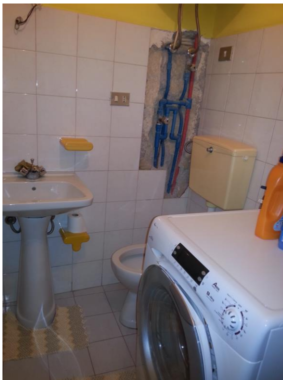
foto 9_ vista del bagno al secondo piano
