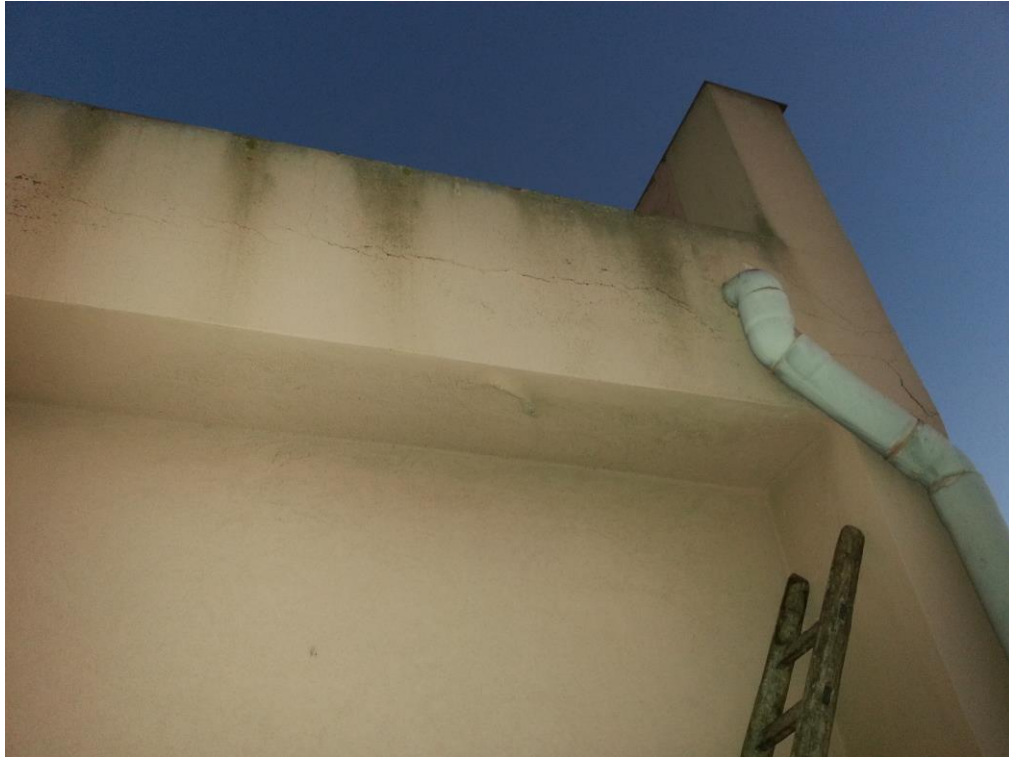
foto 11_ vista della trave esterna
