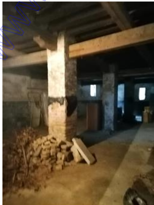
colonne portanti a piano terra
