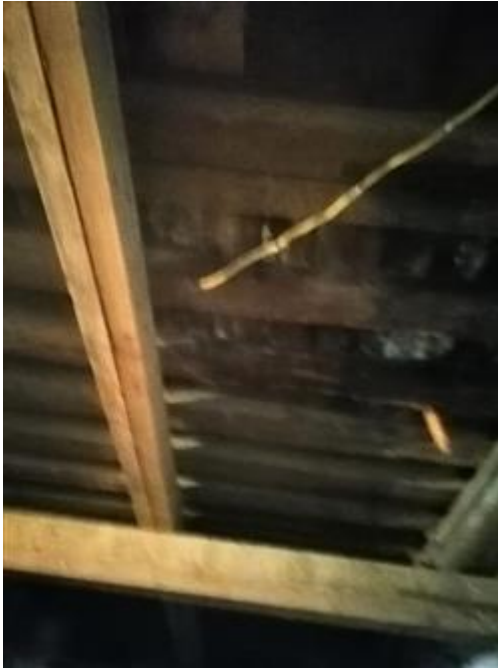
travatura dolai primo piano visto dal piano terra
