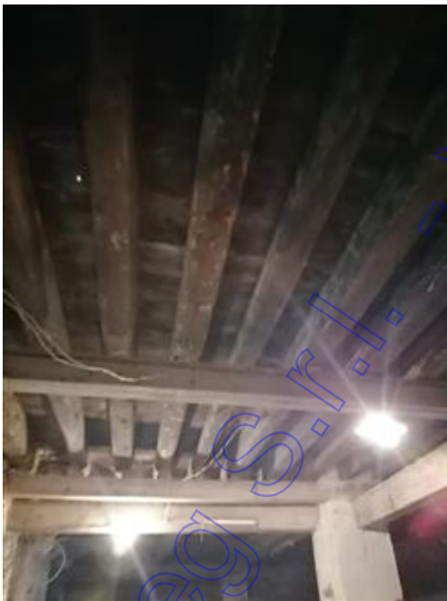
travi di solaio
