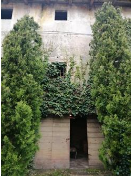
portone di accesso al magazzino a piano terra
