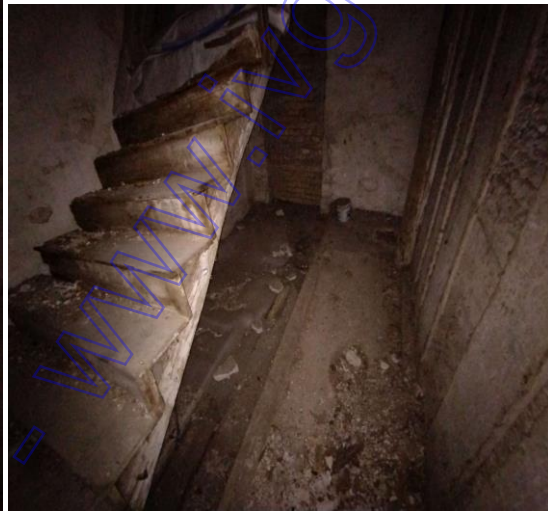
SCALA PERICOLANTE PER ACCEDERE AL SECONDO PIANO
