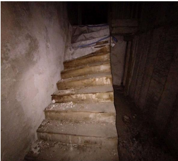
SCALA PERICOLANTE PER ACCEDERE AL SECONDO PIANO
