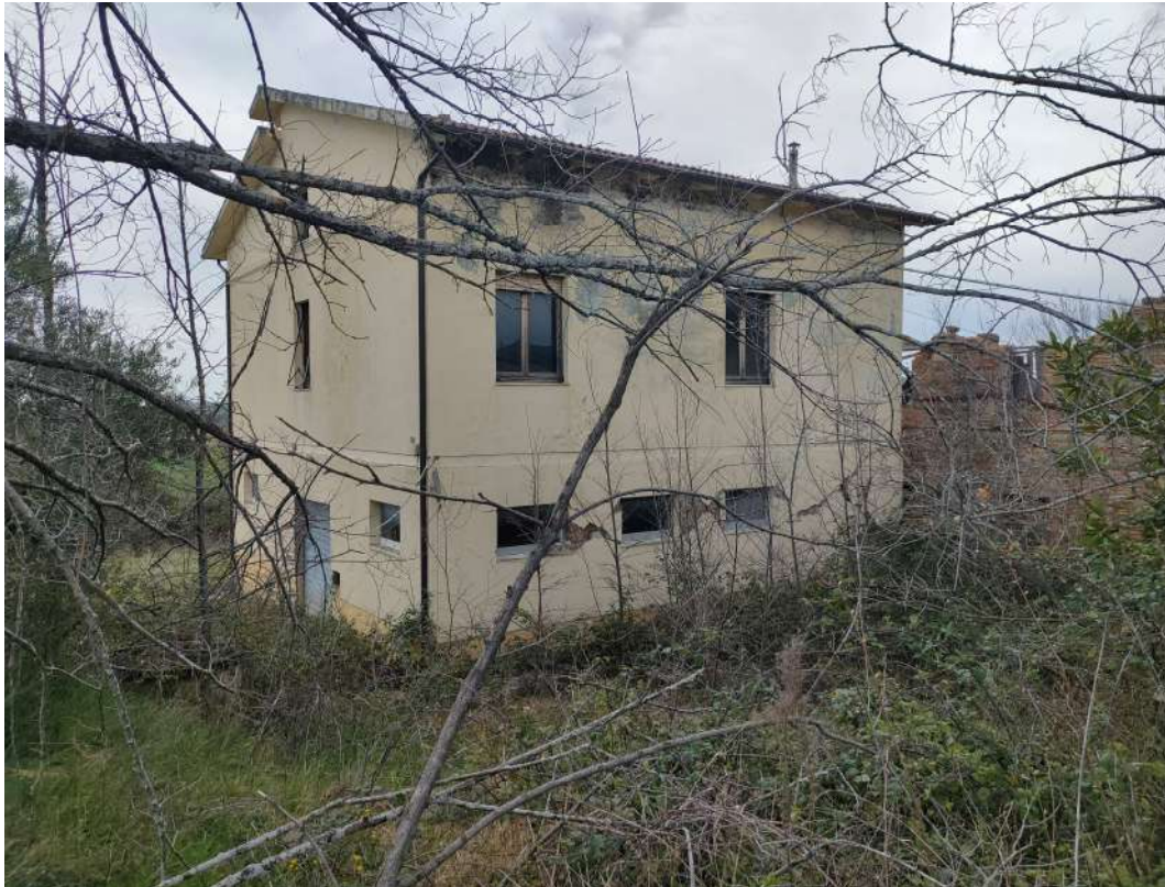
Foto 1 (area sedime fabbricato demolito)
