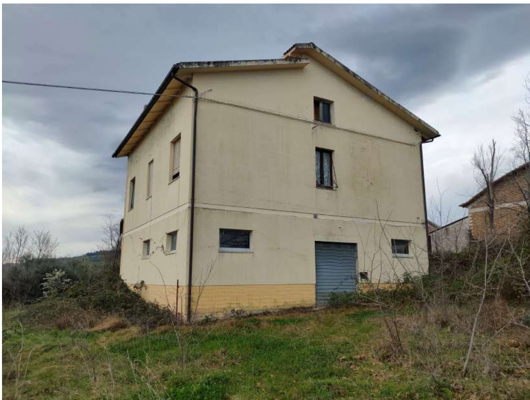
Foto 1 (area sedime fabbricato demolito)
