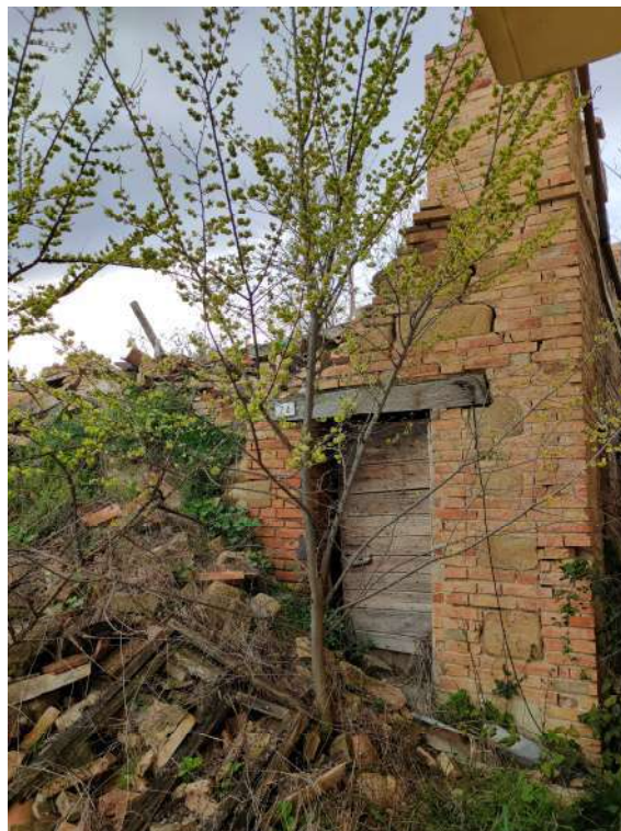
Foto 2 (Particolare prospetto Est)
