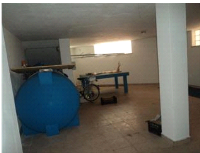
Garage PS1 con serbatoio acqua
