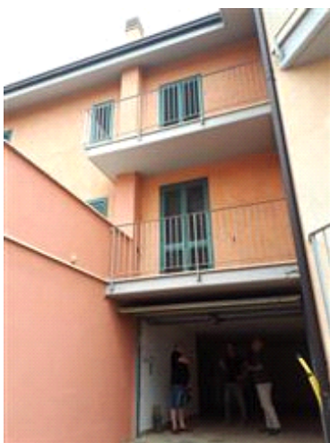
Ingresso garage PS1
