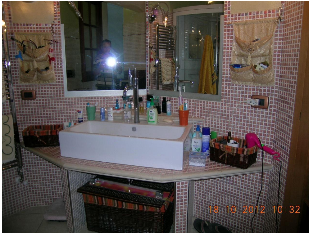
Foto 23/30: Il bagno al piano terra difforme dal progetto in C.E.
