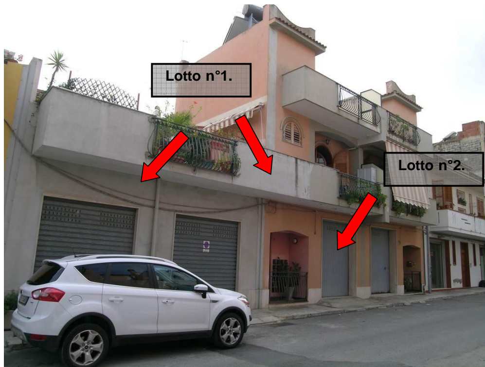
Foto 1/30: I due immobili visti da Nord-est.
