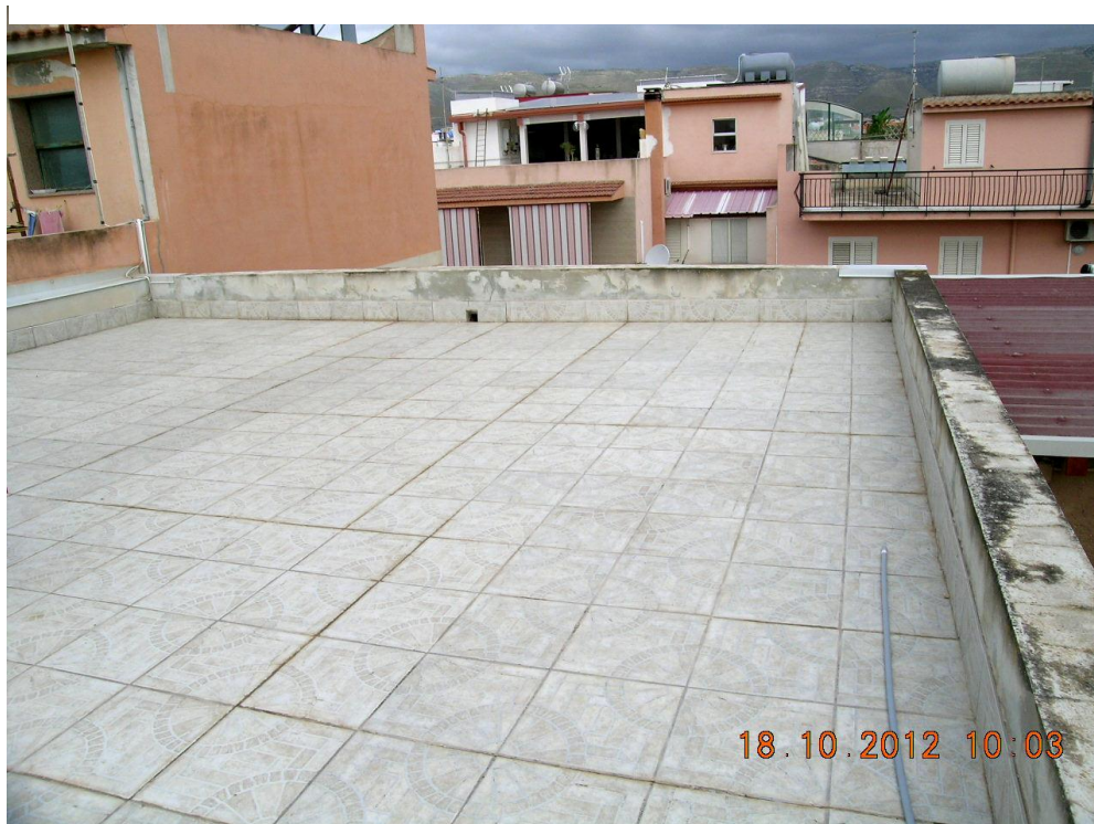
Foto 8/30: La parte direttamente inaccessibile di lastricato solare.
