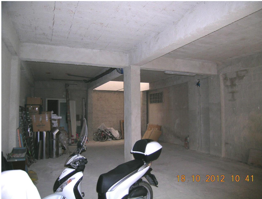
Foto 3/30: Il magazzino non ancora ultimato visto dall'ingresso.
