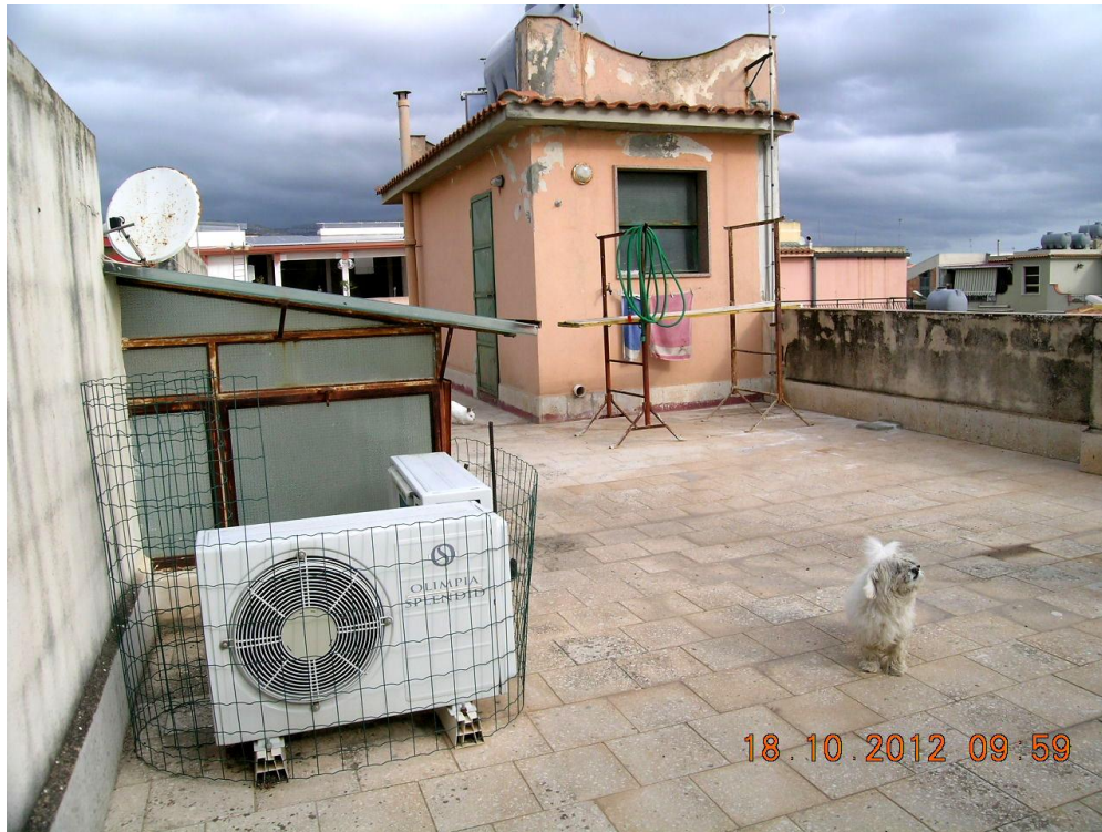
Foto 7/30: Il lastricato solare accessibile dal vano scala
