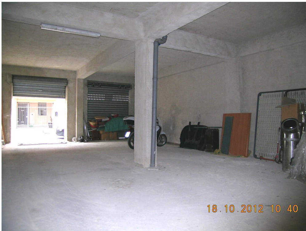
Foto 4/30: Il magazzino visto dall'interno verso la Via Turati.
