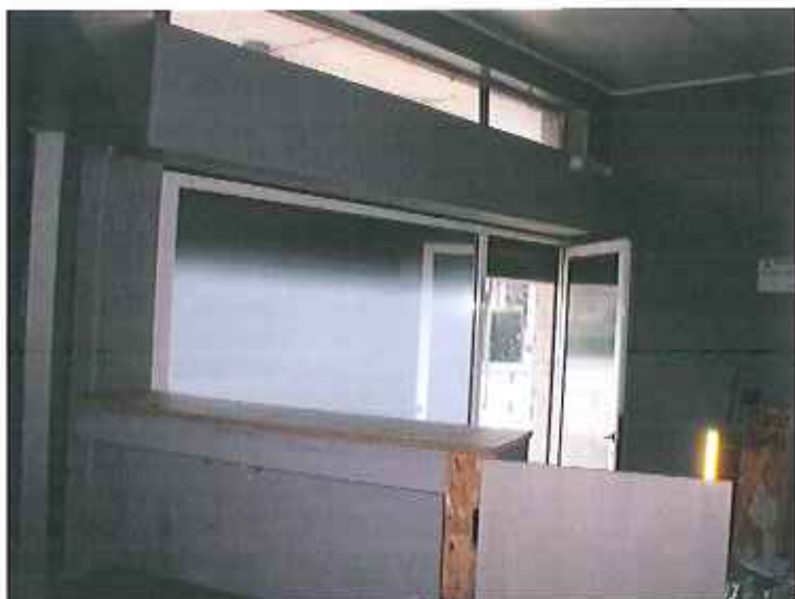
Foto 3 – dettaglio ingresso negozio sub. 3
