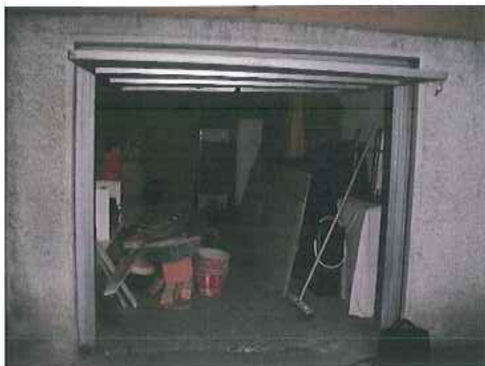
Foto 7 – dettaglio locale magazzino sub. 34
