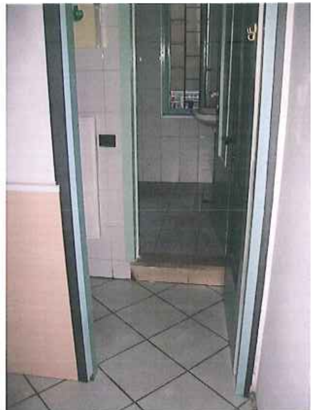
Foto 4 – dettaglio wc con antibagno del negozio sub. 4
