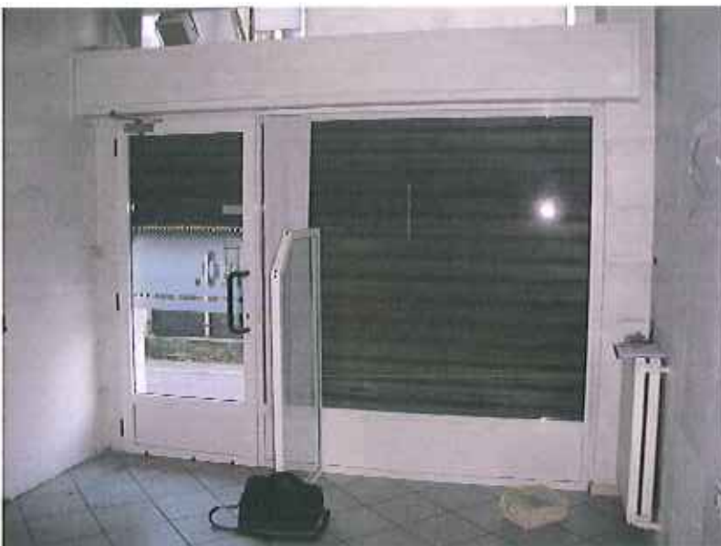
Foto 3 – dettaglio vetrina ingresso locale negozio sub. 4
