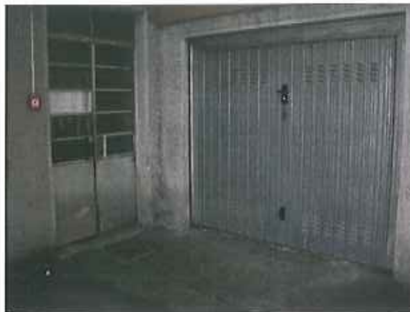
Foto 6 – basculante di accesso al locale magazzino sub. 34 al piano seminterrato
