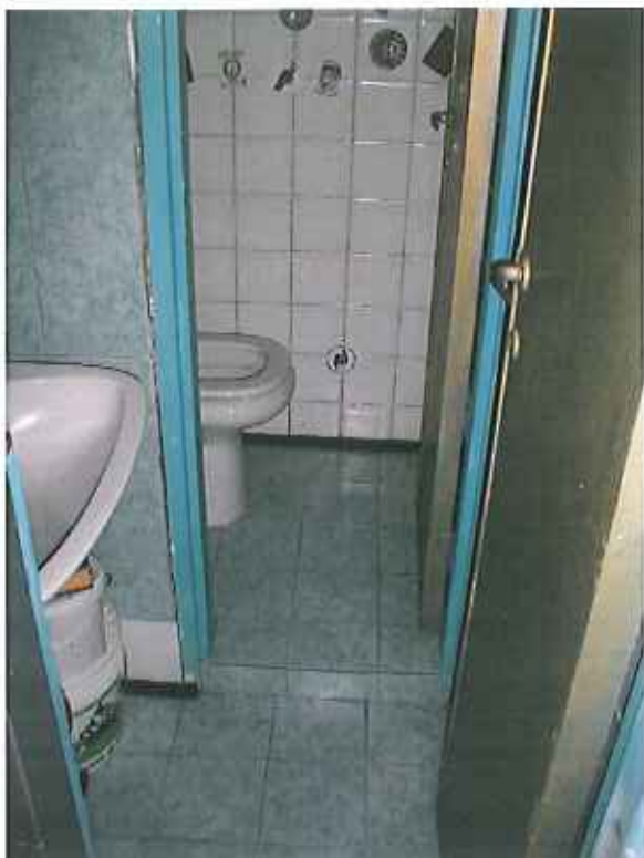
Foto 5 – dettaglio wc con antibagno del negozio sub. 3
