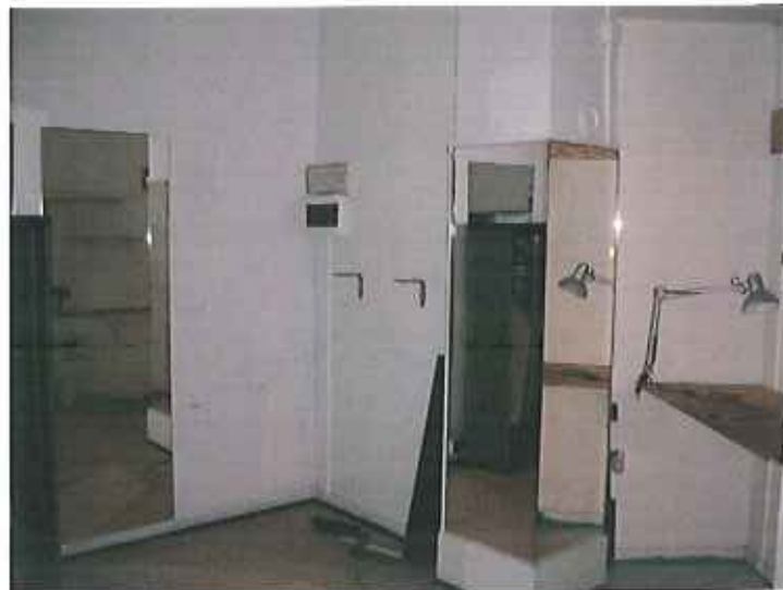
Foto 4 – dettaglio locale interno negozio sub. 3
