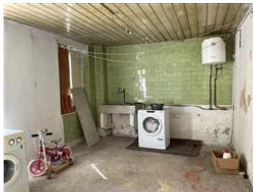
Stanza al piano primo usata come lavanderia.
