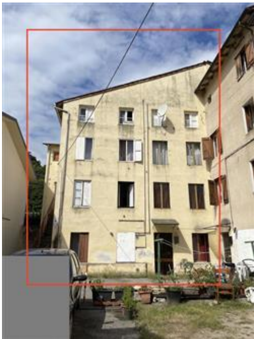
Vista esterna dalla corte (lato sud).
