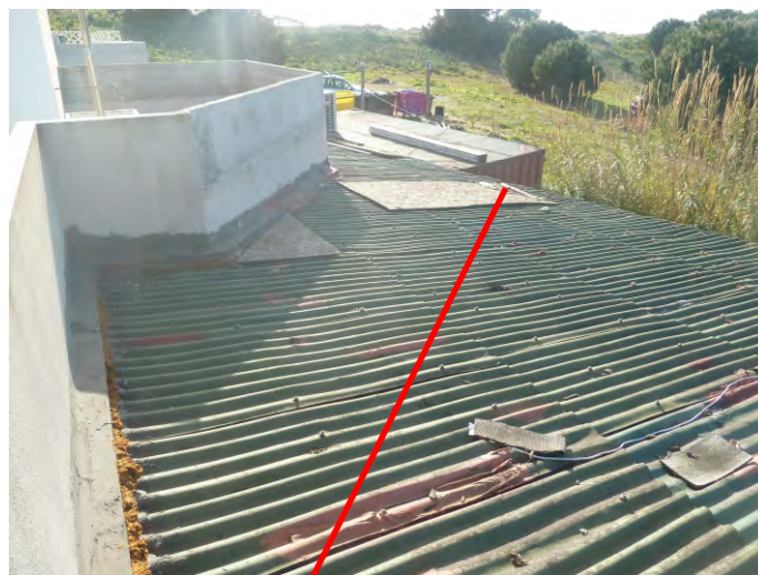
Copertura del cortile sul retro
