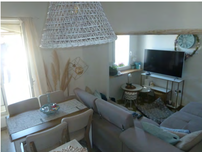
Soggiorno con porzione di tramezzo demolito
