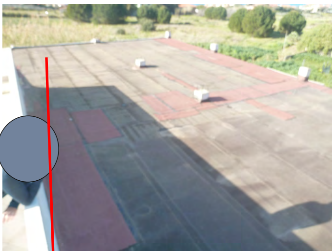
Parte della copertura del cortile sito al PS1
