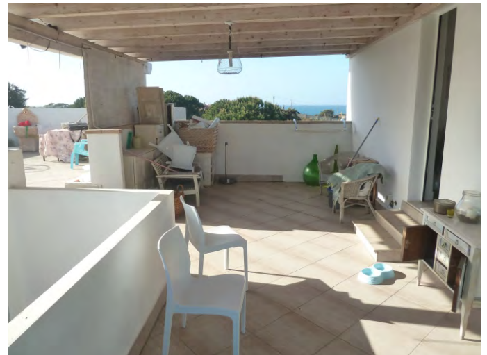
VERANDA E INGRESSO AL PIANO TERRA
