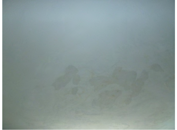
Particolare dei segni da infiltrazioni nel soffitto
