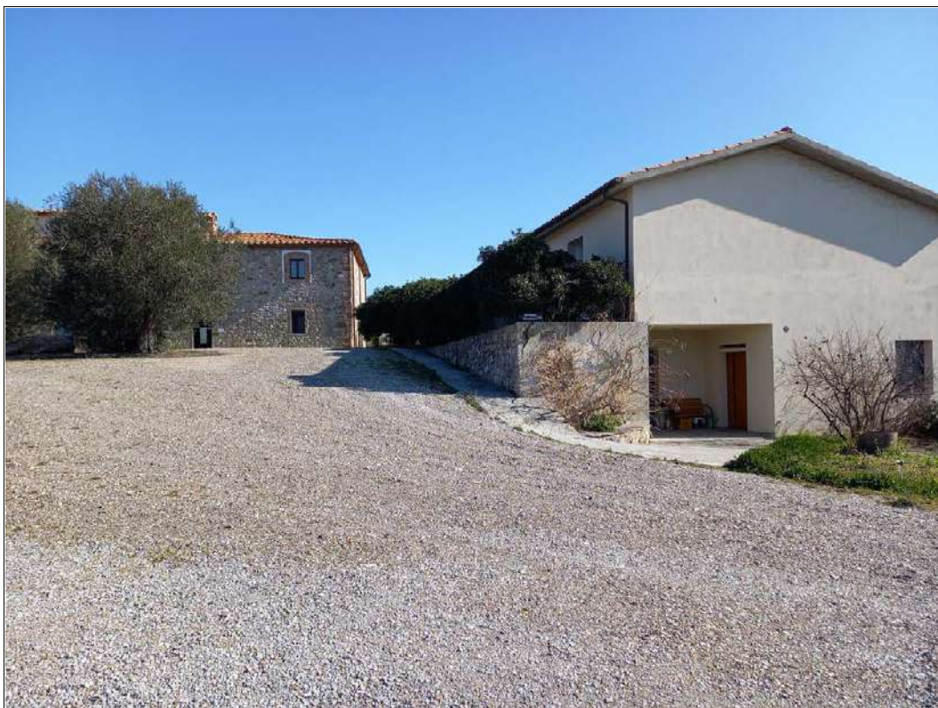
FOTO 54 – Sulla destra il fabbricato posto su tre livelli avente legittima destinazione di magazzino-dispensa-lavanderia (p.lla 109 sub 2, cat. D/10 – Scheda n. 2). Sulla sinistra, in alto, il casale principale. Vista da ovest.
