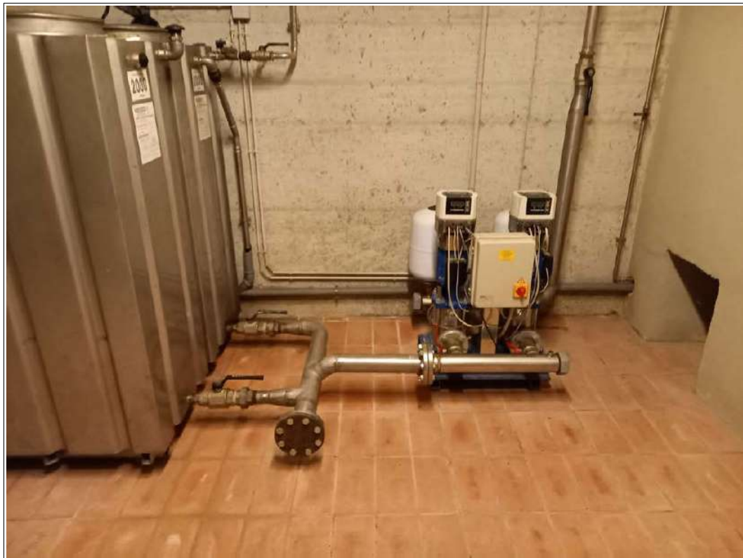
FOTO 19-20-21 – Centrale idrica della cantina: impianto idrico completo di autoclave e 2 serbatoi inox da 2000 LT, filtro filtro a serbatoio Hidrotech
