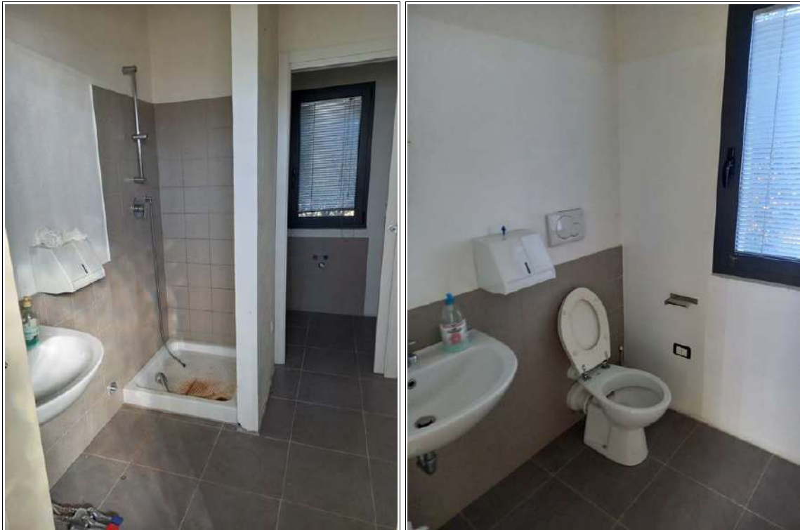
FOTO 100-101 – Servizi igienici nel blocco uffici al piano primo della cantina.
