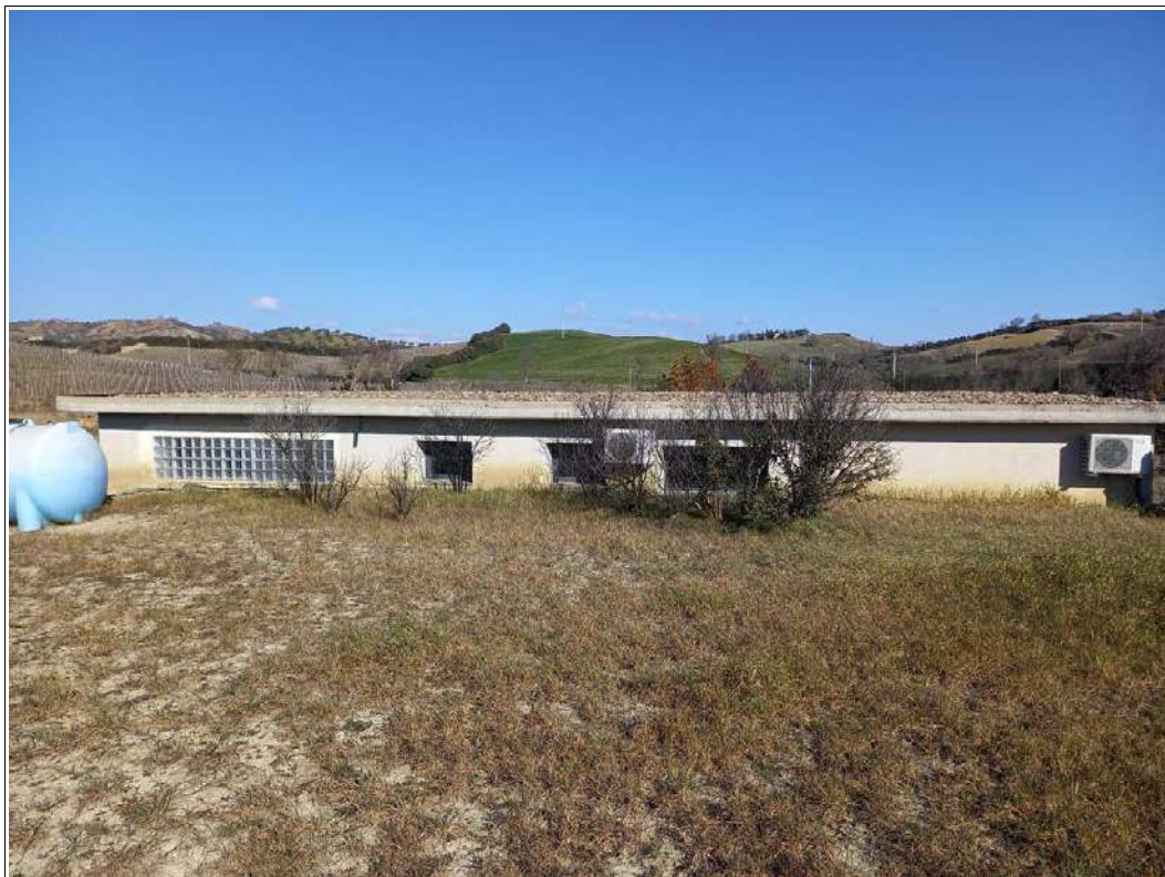
FOTO 85 – Il blocco uffici-servizi visto dalla copertura della cantina.
