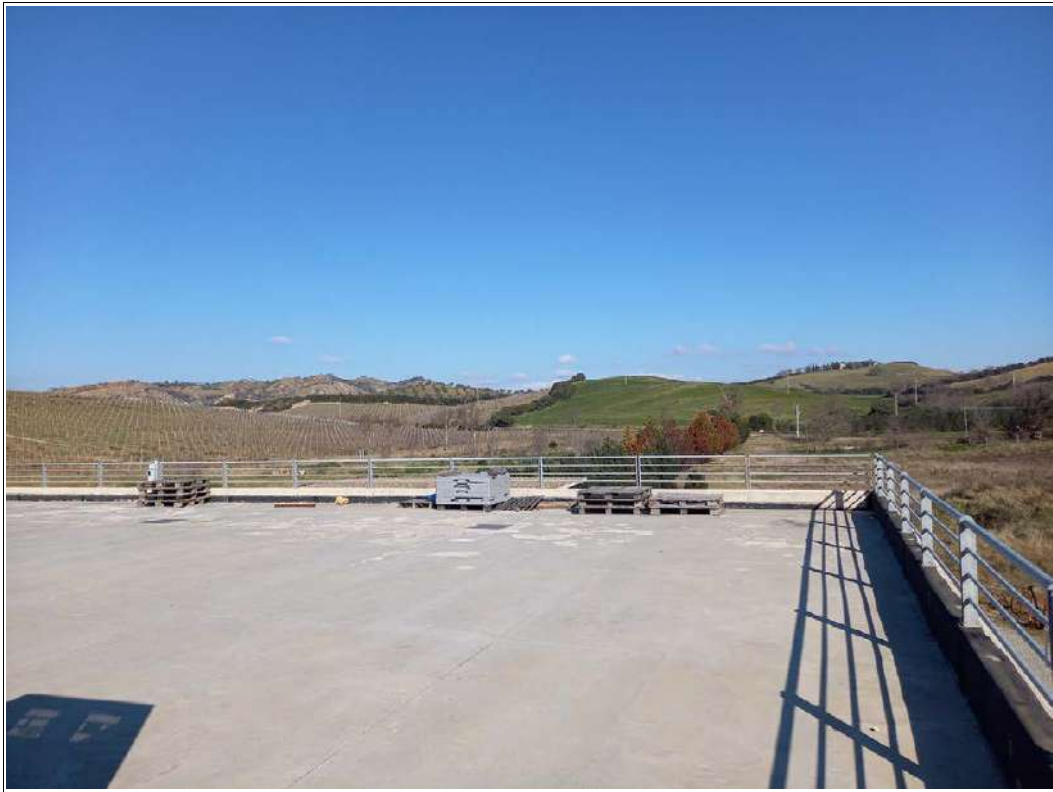
FOTO 84 – La copertura della cantina, accessibile tramite la viabilità di servizio, è carrabile e vi vengono svolte le iniziali operazioni di pigiadiraspatura dell'uva.
