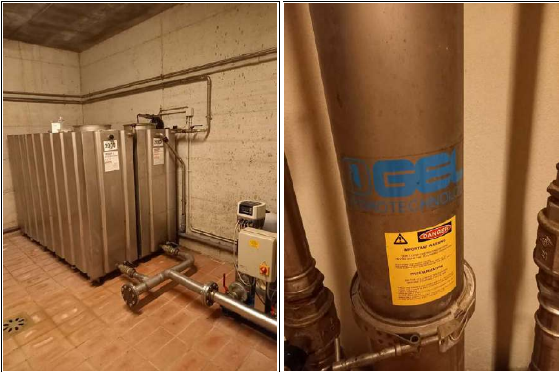
FOTO 19-20-21 – Centrale idrica della cantina: impianto idrico completo di autoclave e 2 serbatoi inox da 2000 LT, filtro filtro a serbatoio Hidrotech
