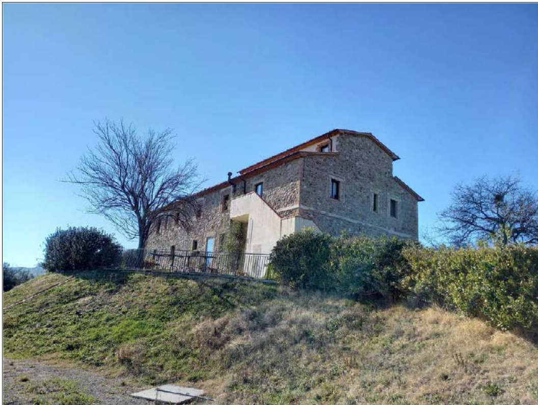
FOTO 5 – Vista da nord-est (dalla piscina) del casale principale del fondo.
