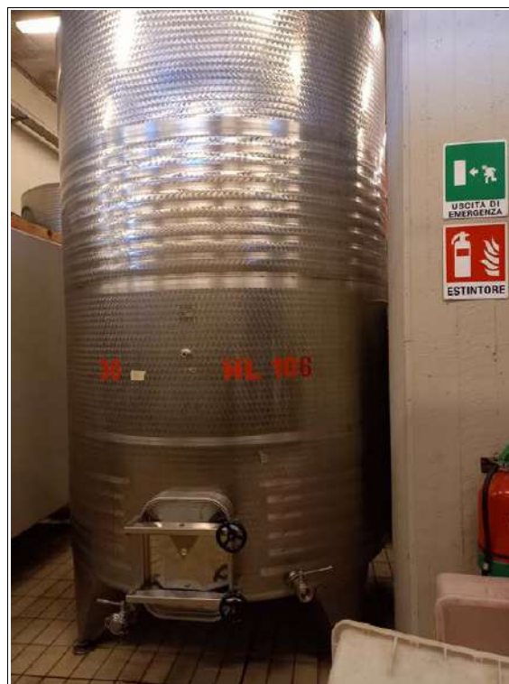
FOTO 12 – Serbatoio in acciaio inox, 106 HL, termo condizionato.
