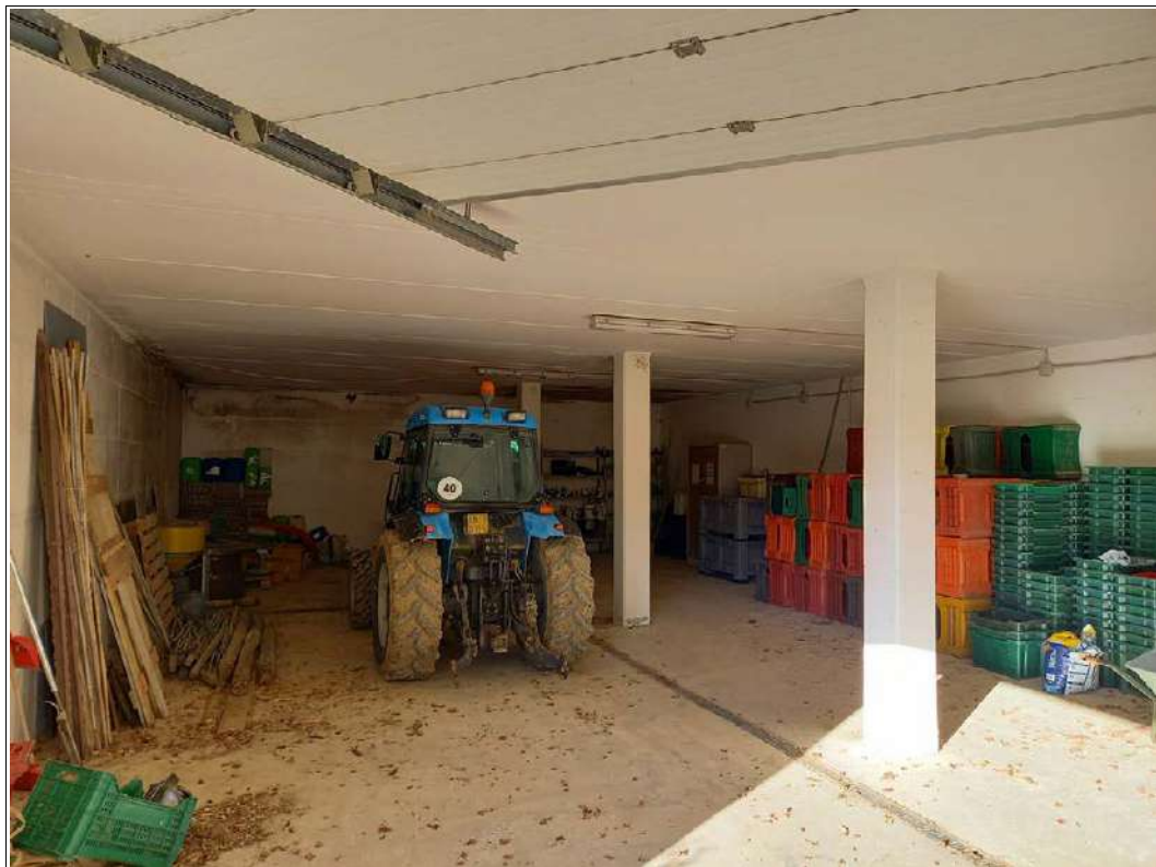
FOTO 77 – Locale magazzino al piano seminterrato del fabbricato magazzino-dispensa-lavanderia.
