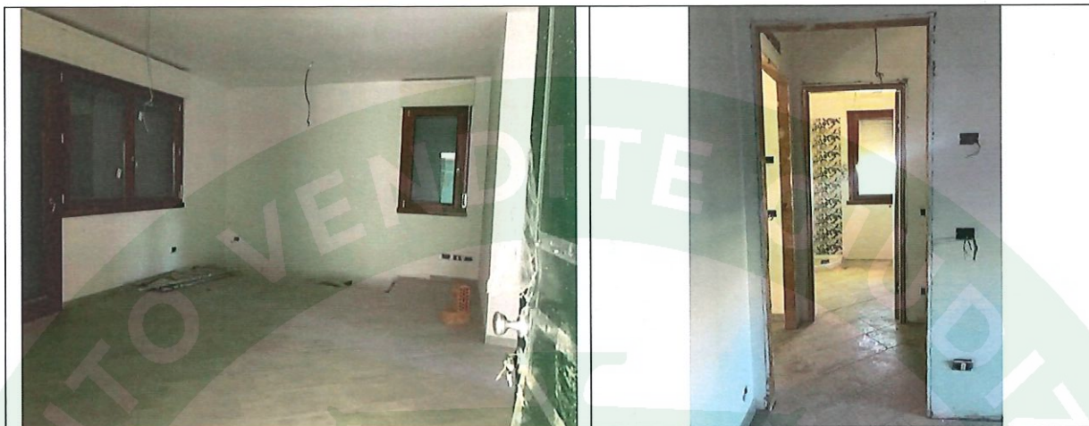
UNITA' IMMOBILIARE 4A - Da completare posa pavimenti e rivestimenti, impianti elettrici e termo-idrosanitari, regolazione serramenti e fornitura/posa porte, zoccolini e tinteggio finale. PERCENTUALE DI COMPLETAMENTO 70%
