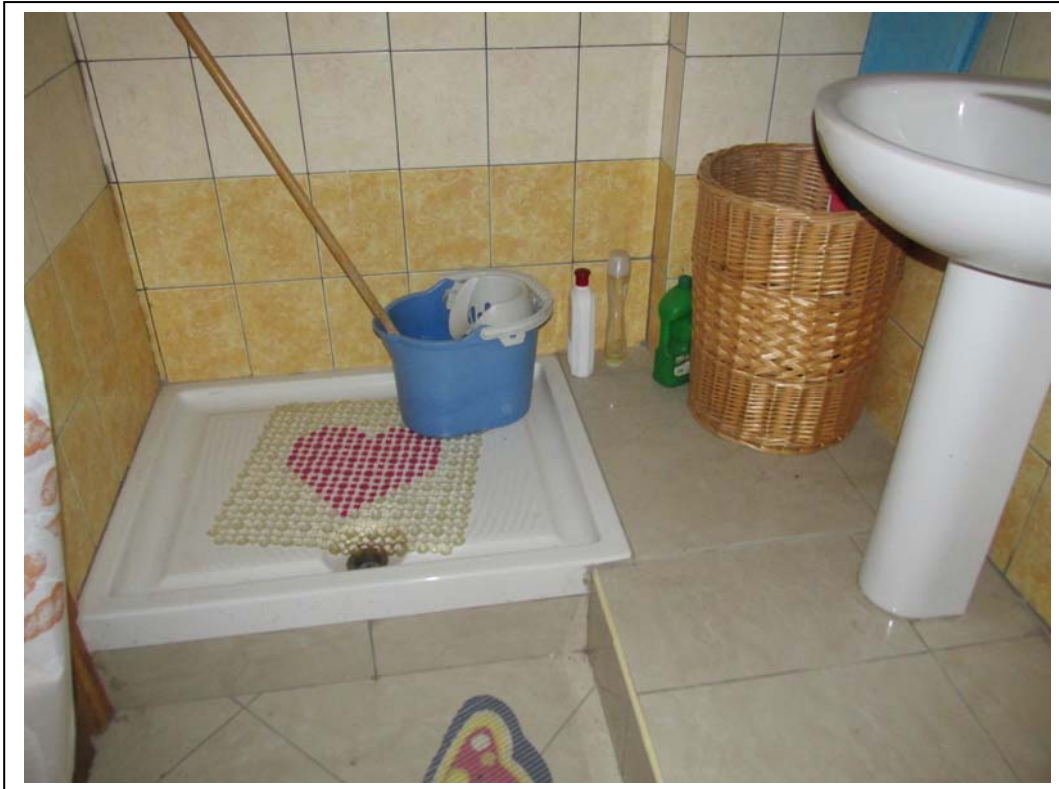
SOFFITTE AL P-2°
