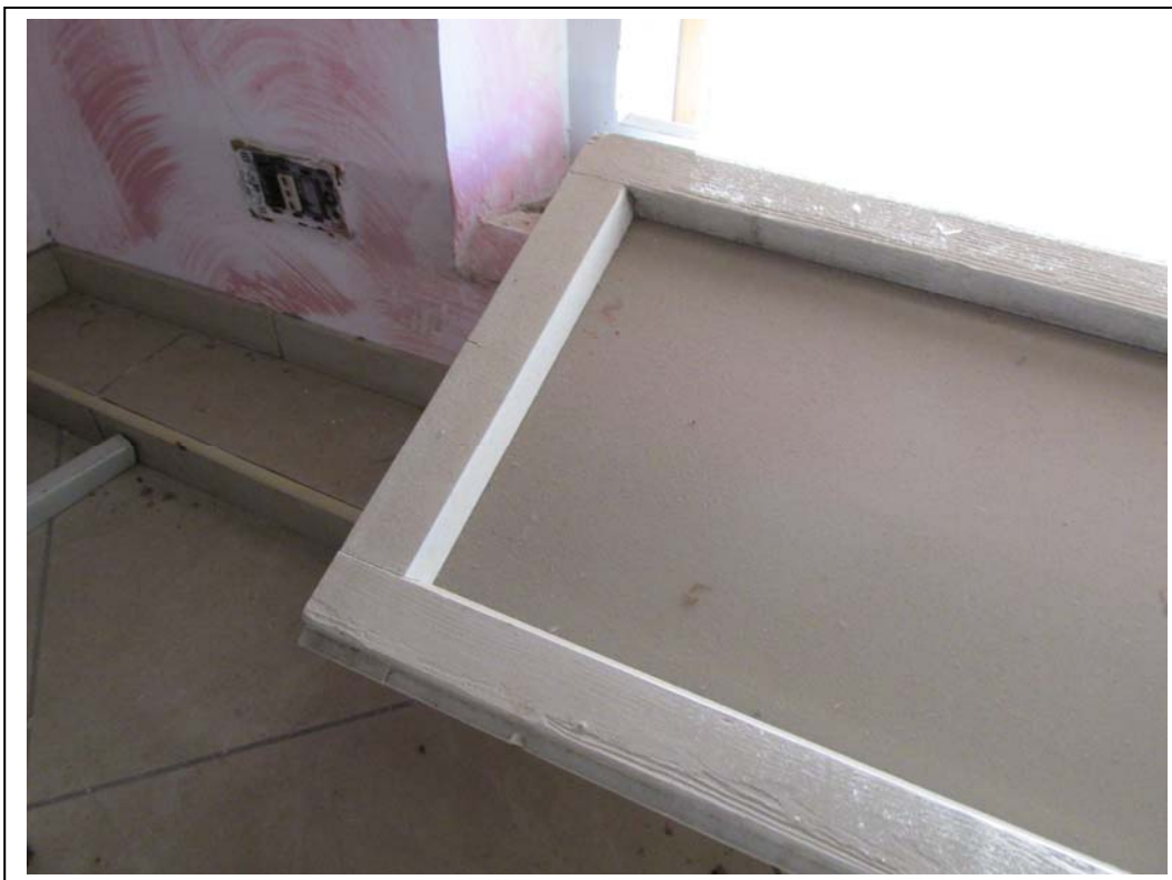
SOFFITTE AL P-2°
