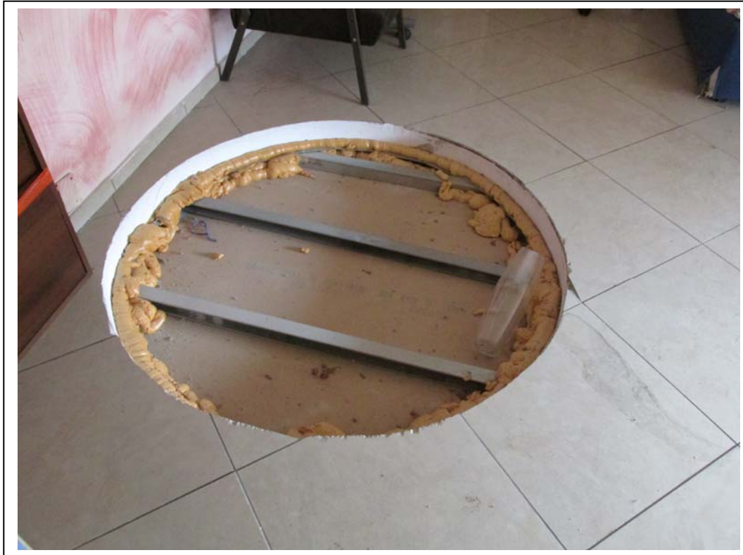
SOFFITTE AL P-2°
