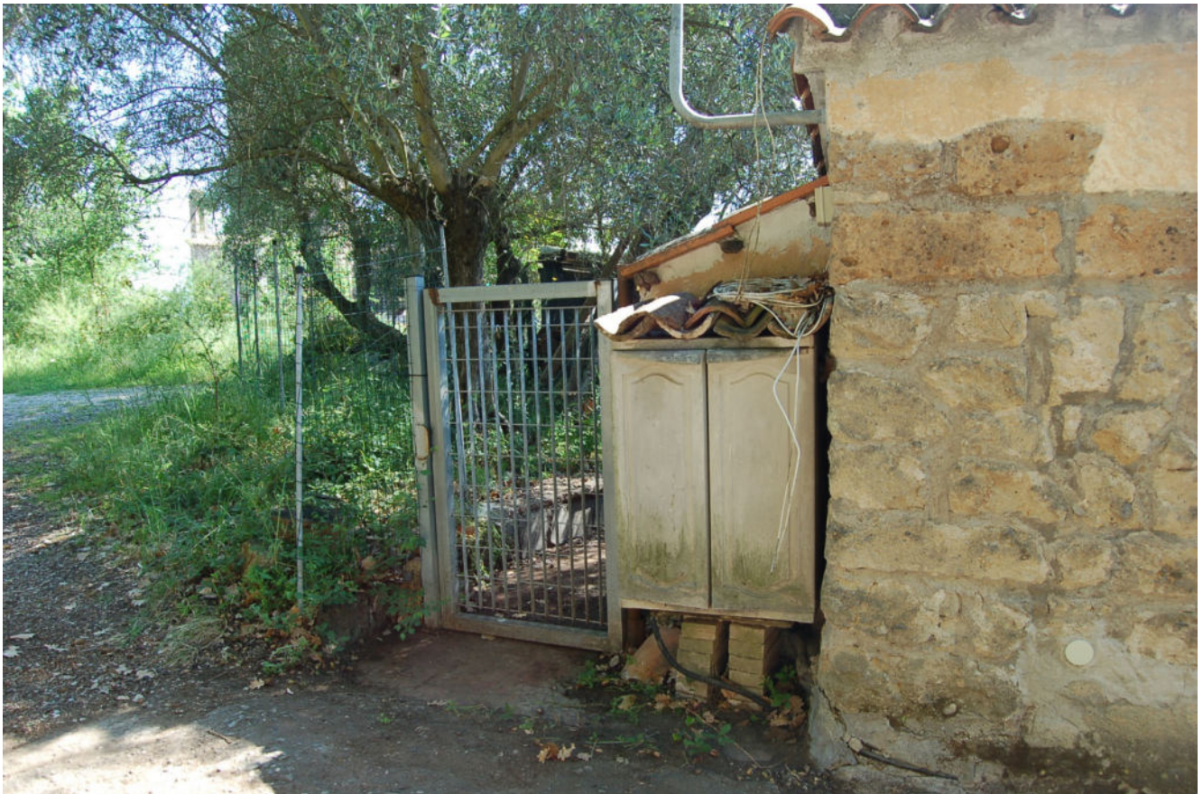
Foto 8 - Ingresso al villino unifamiliare, prospetto ovest
