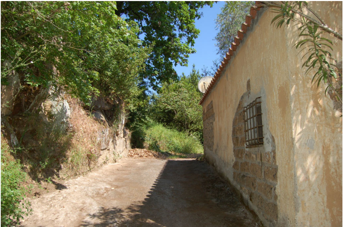
Foto 5 - Parete di confine dell'unità abitativa, prospetto ovest
