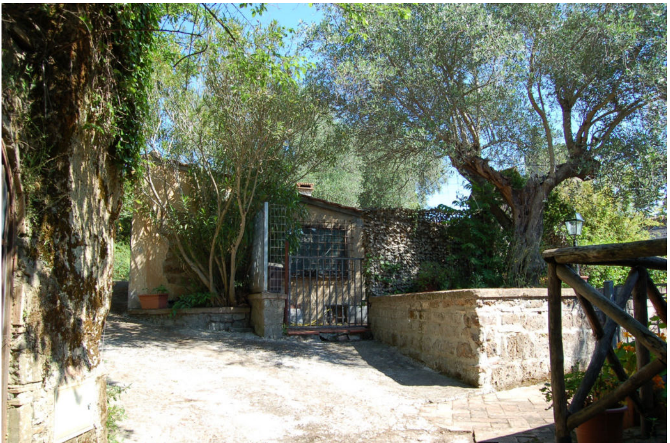
Foto 4 - Ingresso al villino unifamiliare, prospetto sud
