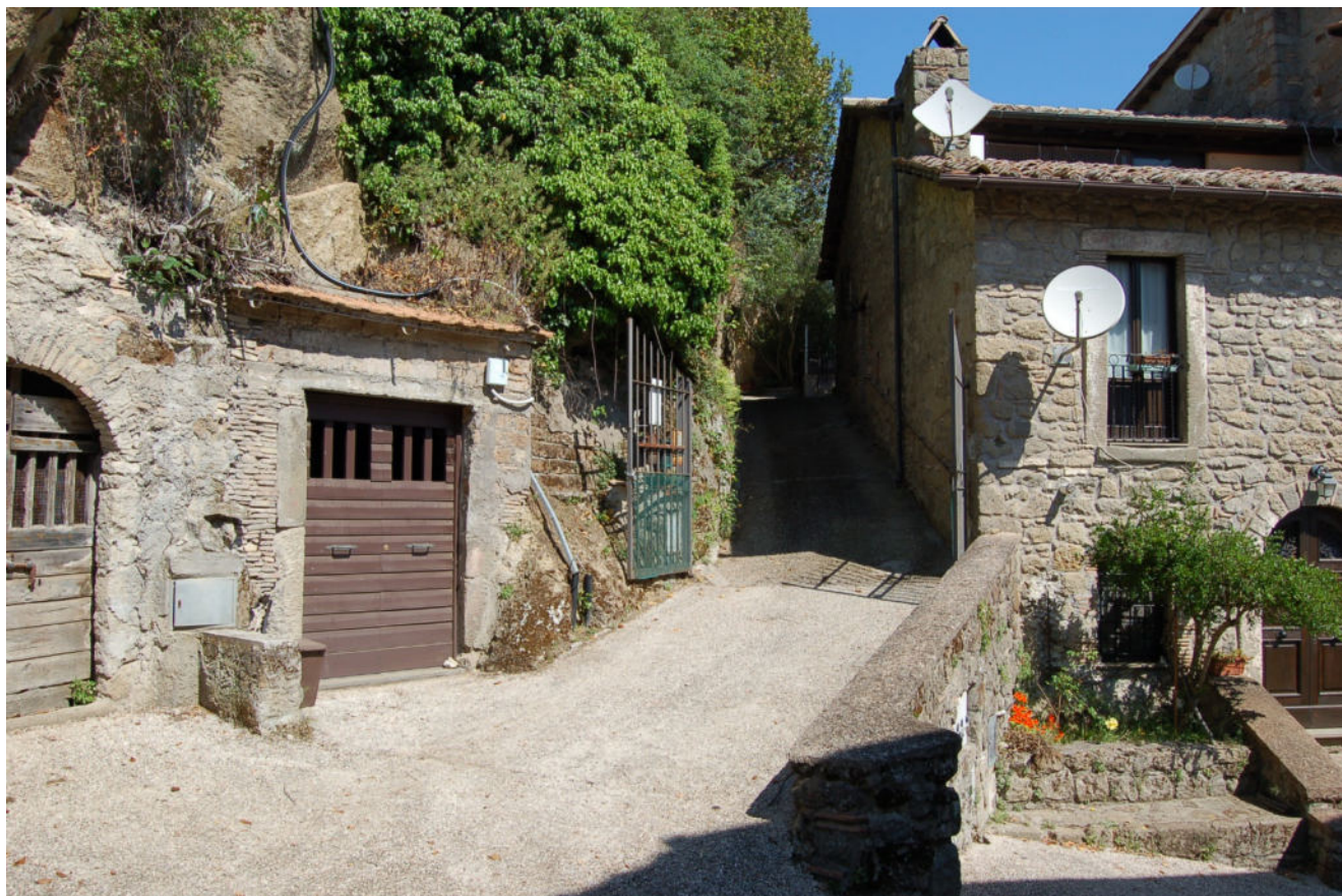
Foto 1 – Ingresso al compendio pignorato da Via Piave, 97
