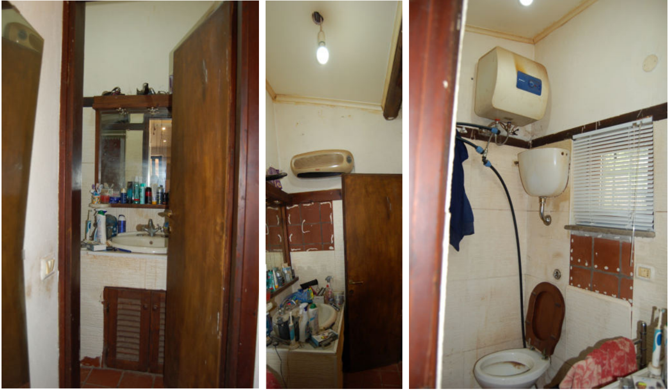
Foto 29 – Vista del bagno
