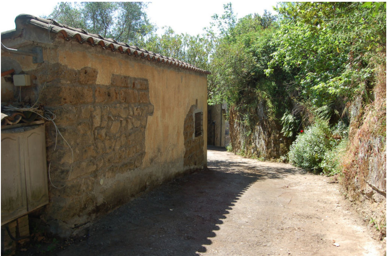
Foto 6 - Parete di confine dell'unità abitativa, prospetto ovest
