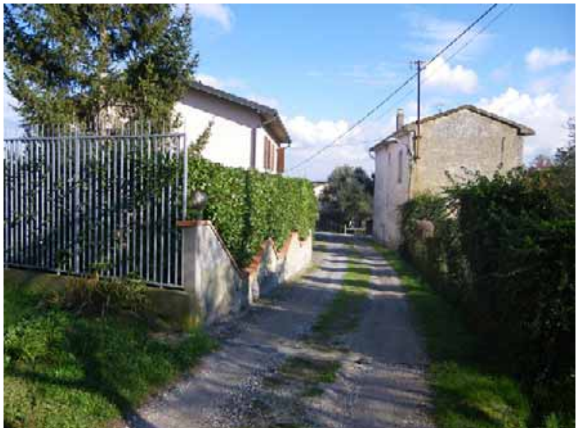
Foto 02: vista d'insieme dell'unità immobiliare dalla strada
