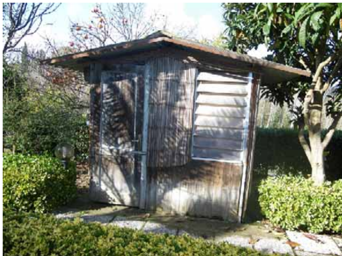
Foto 18: giardino laterale tra unità immobiliare e posti auto con ripostiglio in legno
