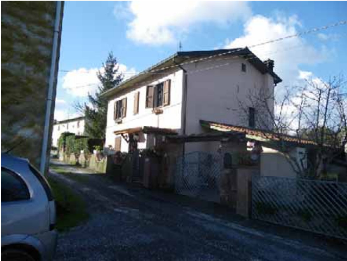
Foto 01: vista d'insieme dell'unità immobiliare dalla strada
