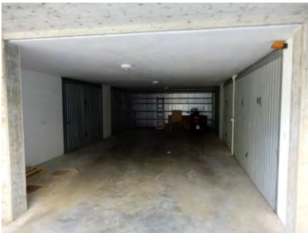
Foto n° 24 – Locali piano seminterrato – vista serranda del sub. 04 da zona di manovra dei mezzi a fine rampa – Foto 12.09.2022
