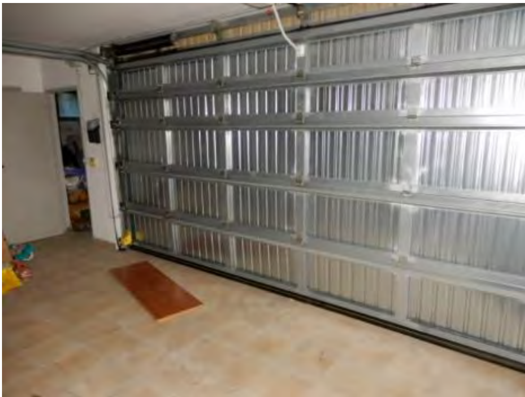
Foto n° 20 – Locale garage subalterno n. 04 – serranda lato Nord con porta di accesso al subalterno n. 05 – Foto 18.03.2023
