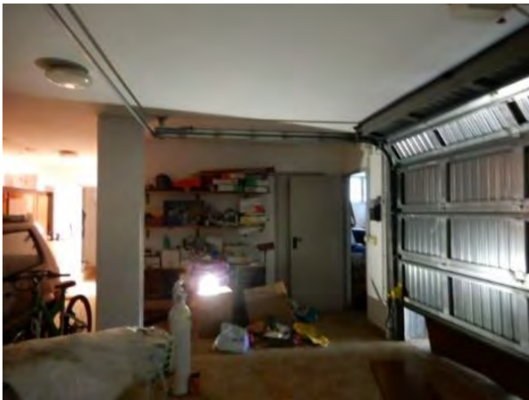
Foto n° 23 – Locali piano seminterrato – vista serranda garage sub. 04 – pilastro delimitazione tra sub. 04 (garage) e sub. 12 (pertinenza abitazione) – porta di comunicazione tra sub. 12 (pertinenza abitazione) e sub. 05 (garage) – Foto 12.09.2022
