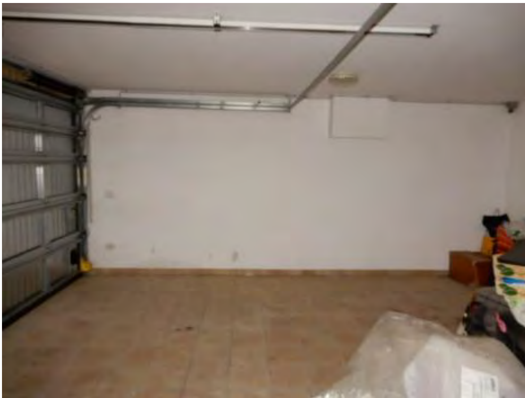
Foto n° 19 – Locale garage subalterno n. 04 – vista parete lato Est – Foto 18.03.2023
