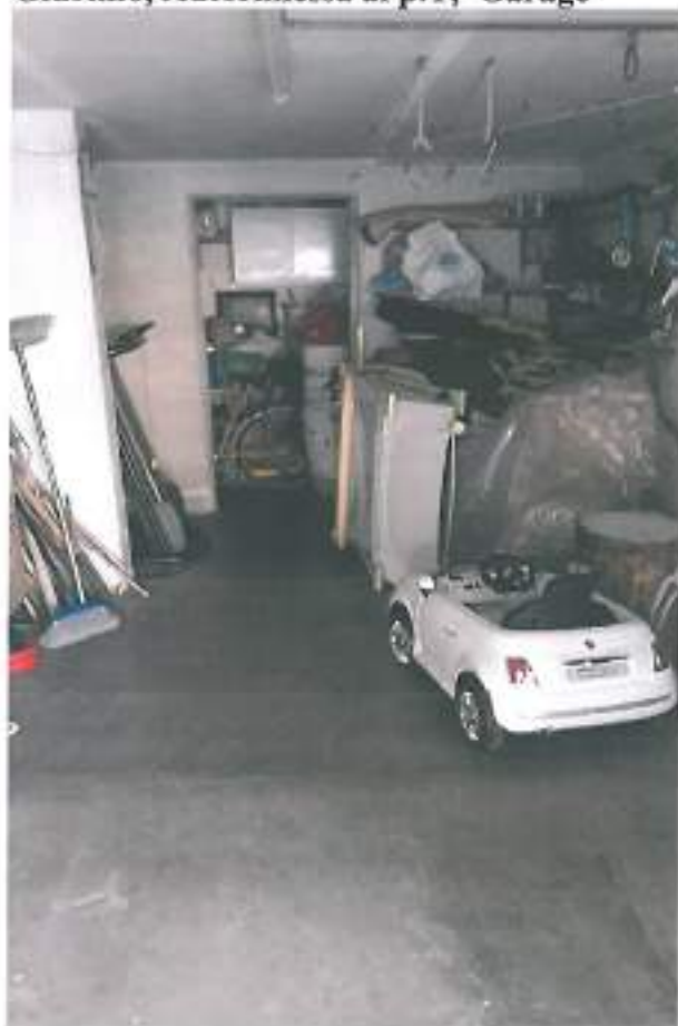
Foto n. 17: Vista interno, foglio 75, part. 186 sub 4, Via XX Settembre Selci Lama, San Giustino, Autorimessa al p.T, Garage
