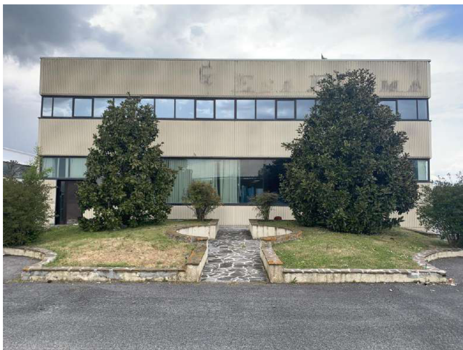
Foto 2 - Facciata sud ovest
