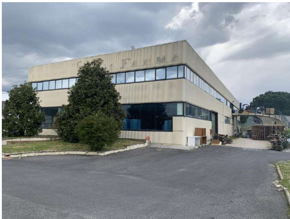
Foto 3 - Facciata sud est
