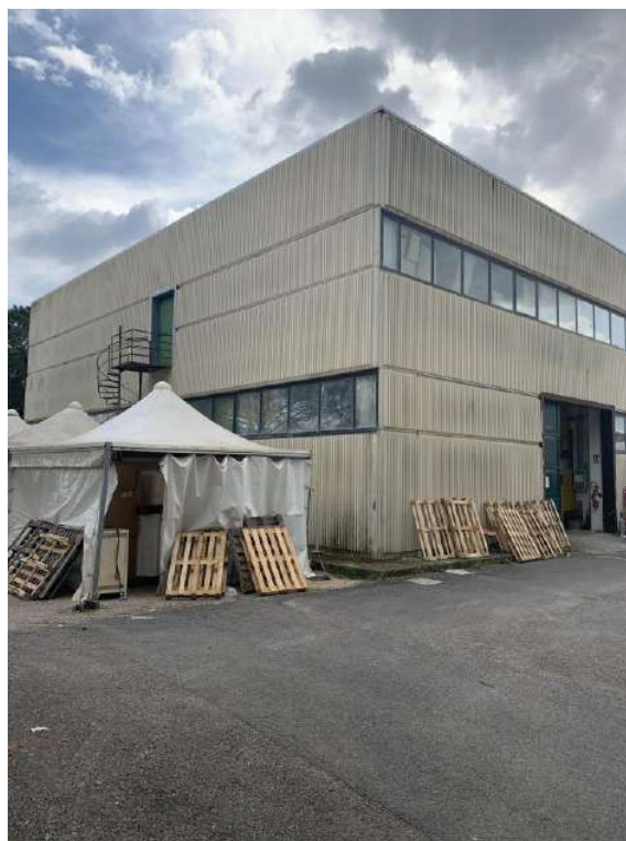
Foto 5 - Facciata nord est
