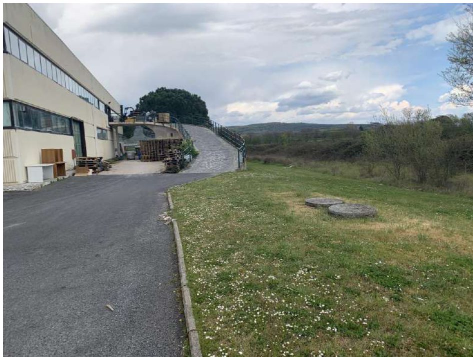
Foto 4 - Facciata sud est
