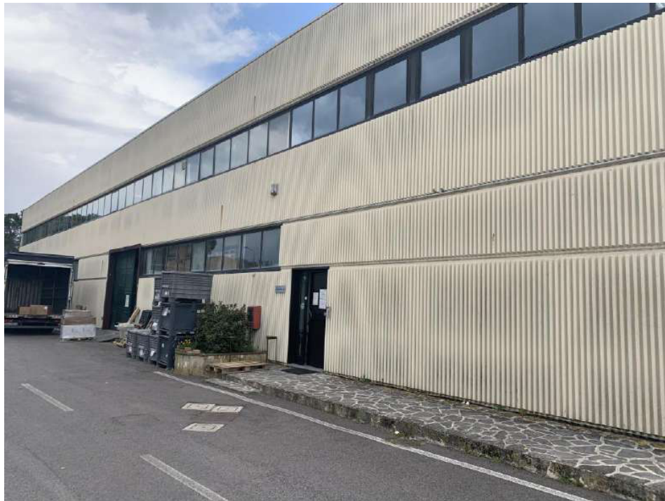
Foto 3 - Facciata nord ovest
