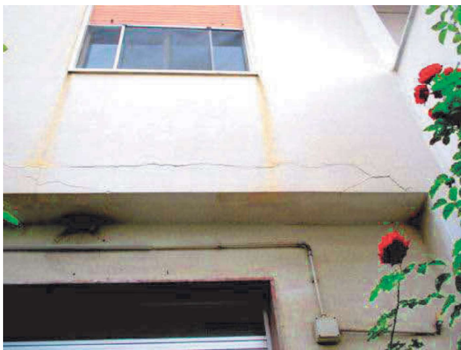
Foto 5 -particolare del prospetto- finestra del vano di ingresso dell'appartamento
